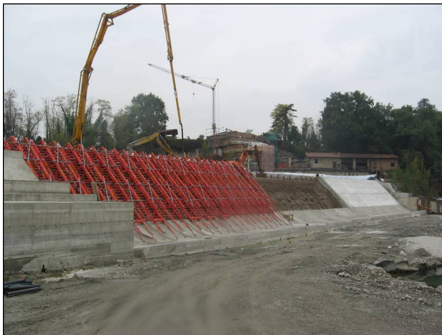
FIGURA 6 – DETTAGLIO DELLA TRAVERSA IN COSTRUZIONE SUL FIUME RENO A PONTECCHIO MARCONI)
