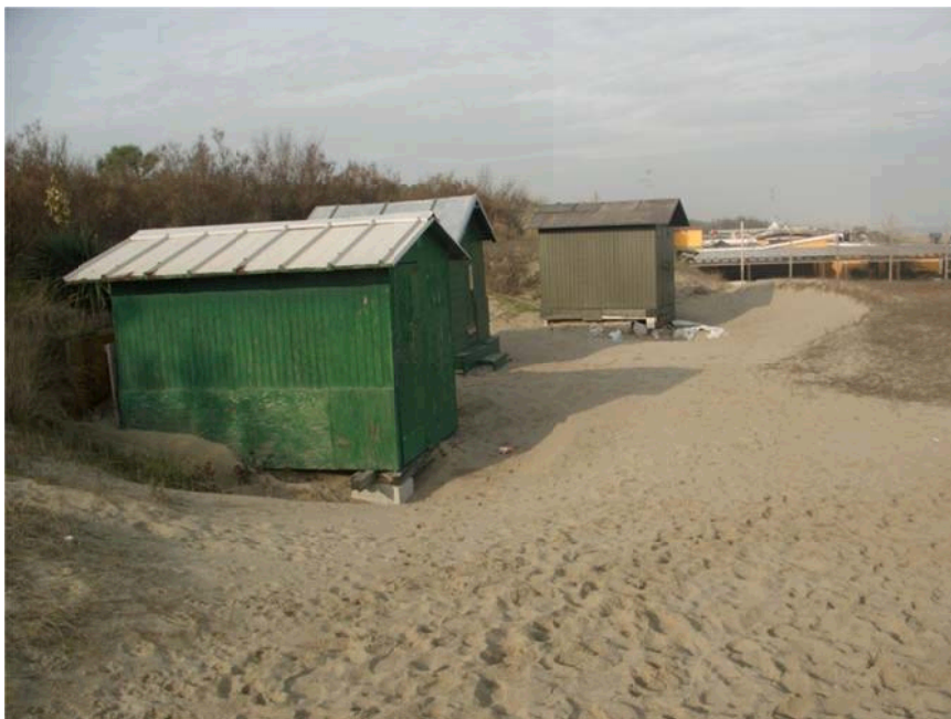
FIGURA 13 – CAPANNI DI SERVIZIO ALLA BALNEAZIONE SOPRA E A RIDOSSO DI RELITTII DI DUNA
