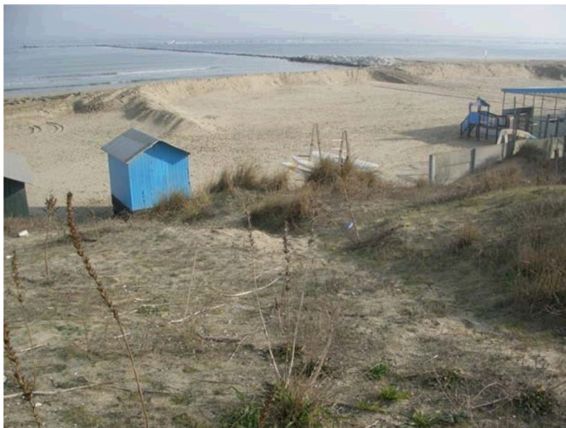
FIGURA 7 – DUNA ARTIFICIALE REALIZZATA IN PERIODO INVERNALE A PROTEZIONE DALLE MAREGGIATE
