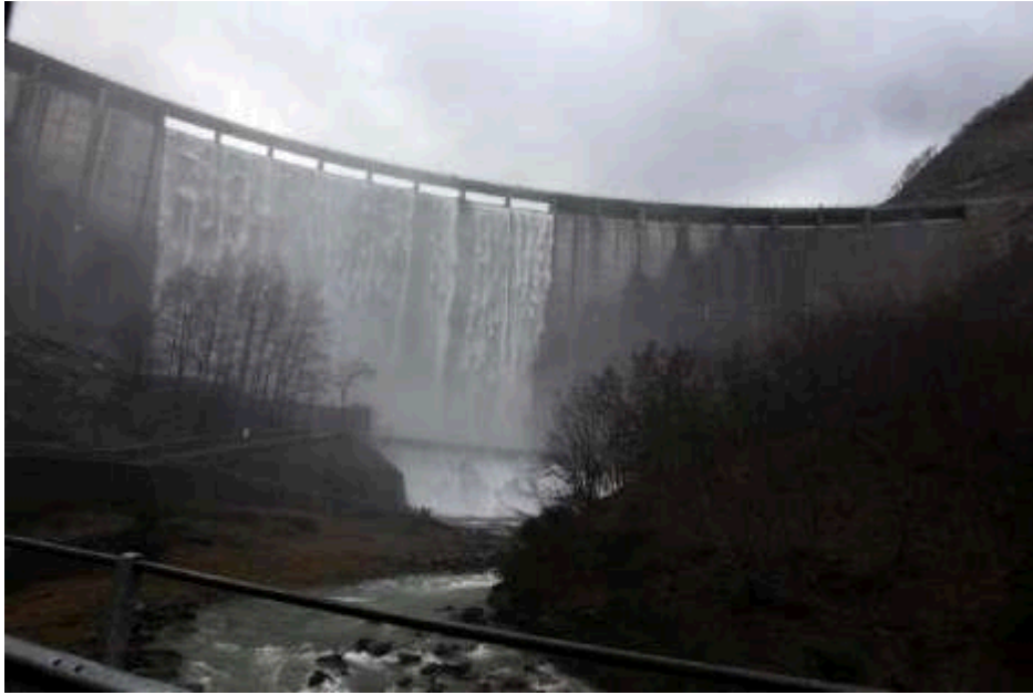
2 – Diga di Ridracoli, con tracimazione naturale tramite scarichi di superficie
