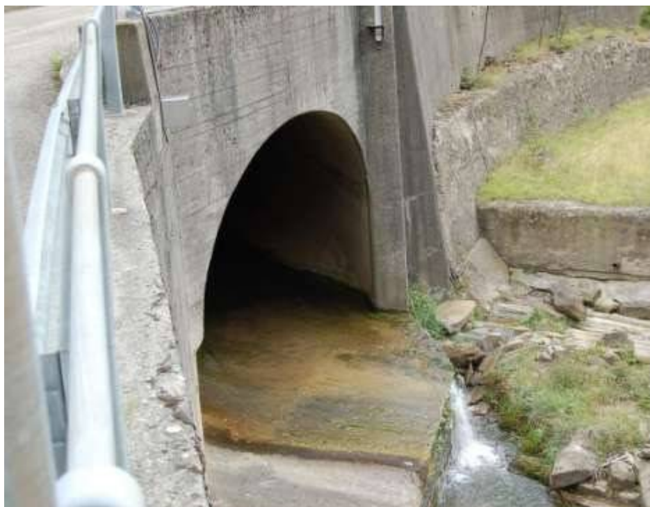
Figura 4 – Tratto del Bidente di Ridracoli; immissione dello scarico di fondo nel Torrente Bidente di Ridracoli
