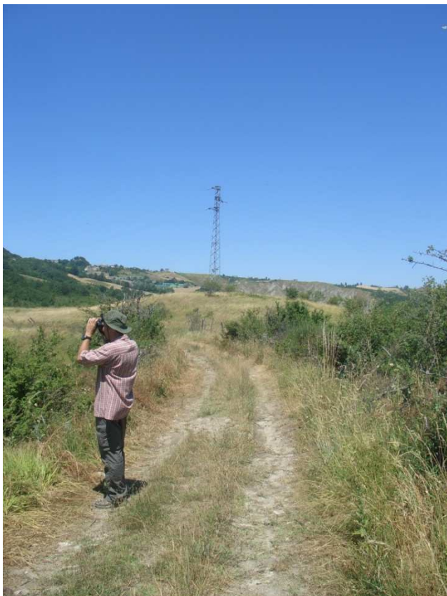
FIGURA 8 – SULLO SFONDO TRALICCIO DI LINEA MT SUL VERSANTE EST DEL MONTE ERCOLE (ZONA TRA LOC. VILLA VERDE E LOC. LE MACCHIE)
