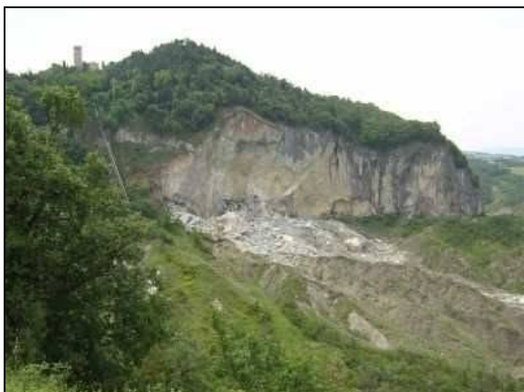
FIGURA 9 - FORTE DI SAN LEO – FONTE: AMBIENTE.REGIONE.EmiliaRomagna.it/Geologia/...GEOLOGICO/...GEOLOGIC.
