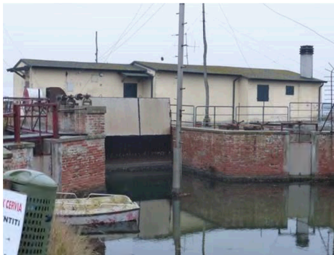
FIGURA 138 – CHIUSA SUL CANALE IMMISSARIO LUNGO VIA DEL VALLONE (FOTO BIOPROGRAMM, 2/01/2016).
