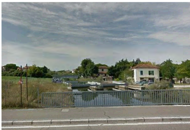
FIGURA 139 – CHIUSA SUL CANALE EMISSARIO.
