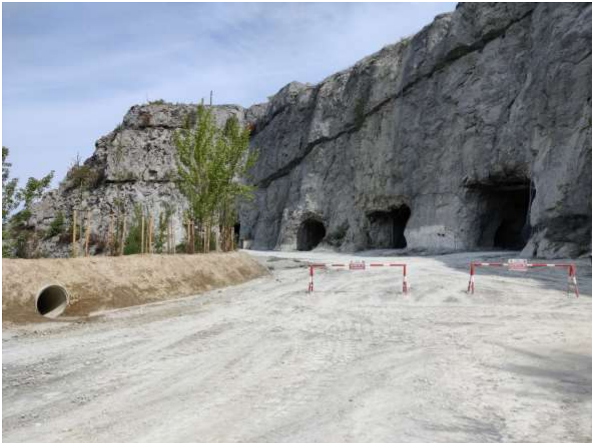
Foto 9 - Ingresso gallerie a quota 220 m s.l.m. (foto di Servin)
