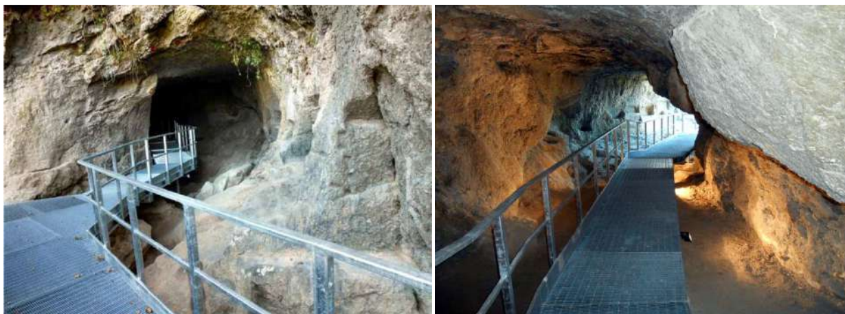
Figura 7-40 - Veduta dell'ingresso della grotta sia dall'esterno che dall'interno, con ballatoio e rampa pedonale (da Negrini, Poli 2018, p. 121)
