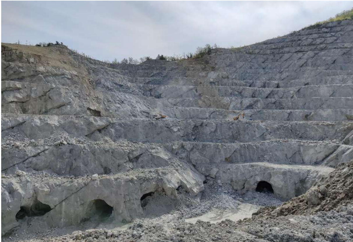
Figura 7-8 – Particolare del fronte di cava nella zona centrale, ove la roccia gessosa si presenta maggiormente fratturata per ragioni tettoniche
