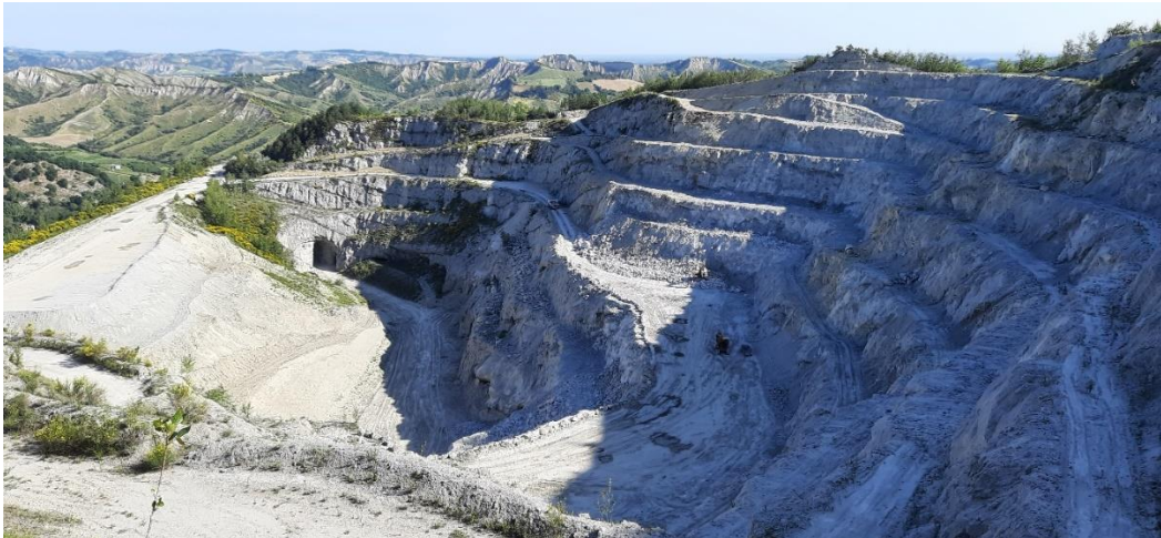
Figura 7-3 – Vista della Cava Nord, situazione attuale (foto S. Marabini – maggio 2021)
