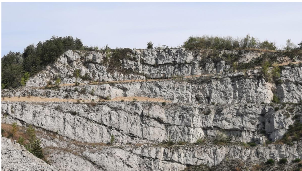
Figura 4-5 – Recupero ambientale in corso sul versante settentrionale (foto P. Rigoni – aprile 2021)
