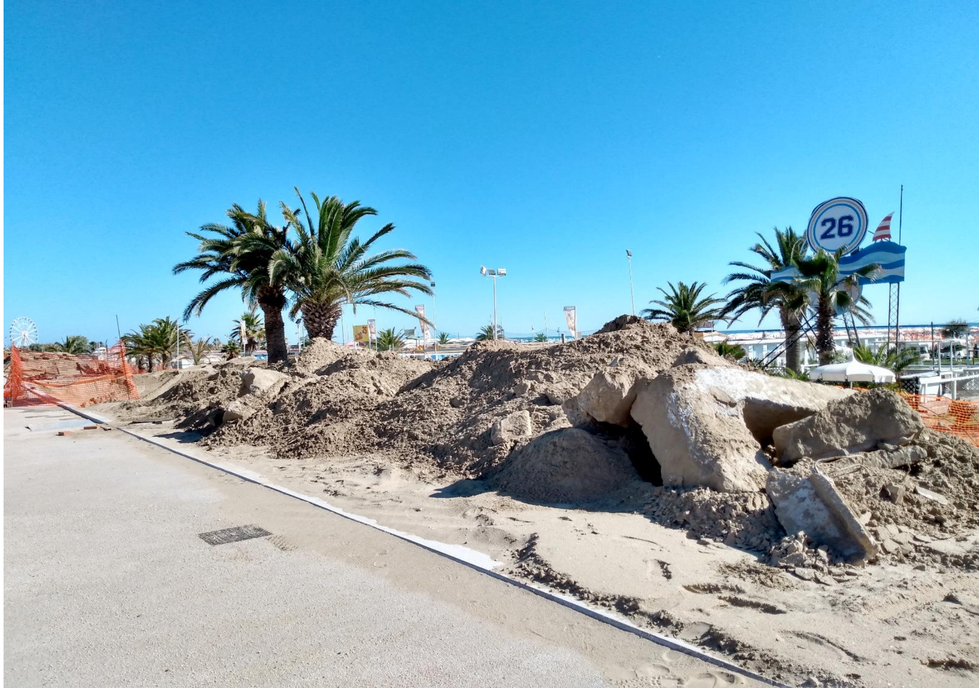
RIGENERAZIONE DELLE AREE COSTIERE E DEI PORTI E ADATTAMENTO AI CAMBIAMENTI CLIMATICI | 8 novembre 2022 | Sala Reclaim Expo | Ecomondo
