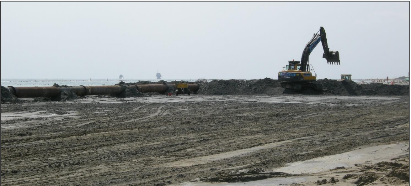
Figura I.4.2-6: Alcune operazioni condotte in fase di cantiere Progettone 2 a Punta Marina
