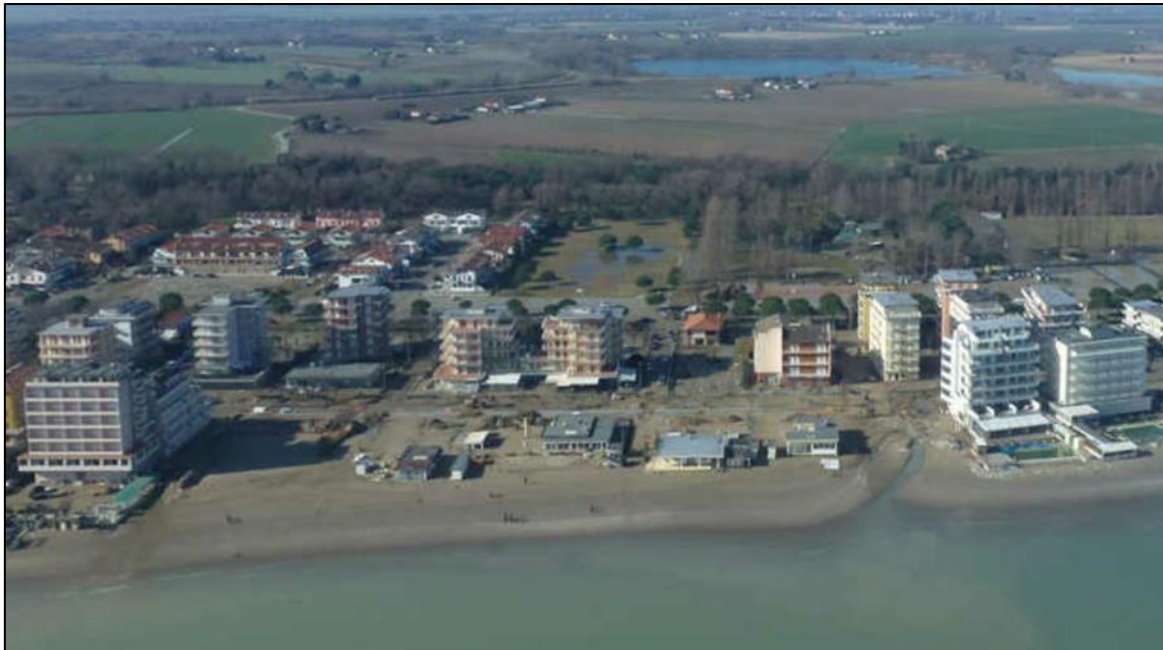
Figura I.2.2-8: Canale di deflusso (Lido di Savio)
