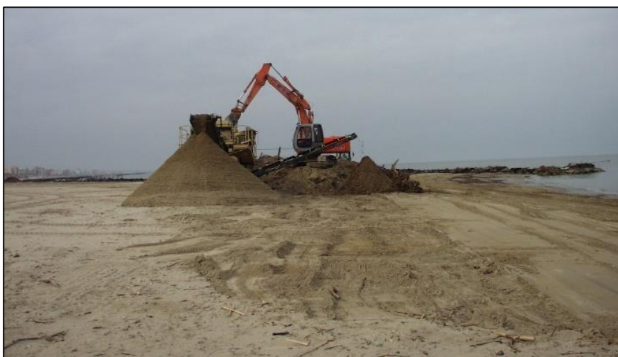
Figura I.4.2-16: Attività di vagliatura della sabbia preliminare alla fase di spargimento in spiaggia
