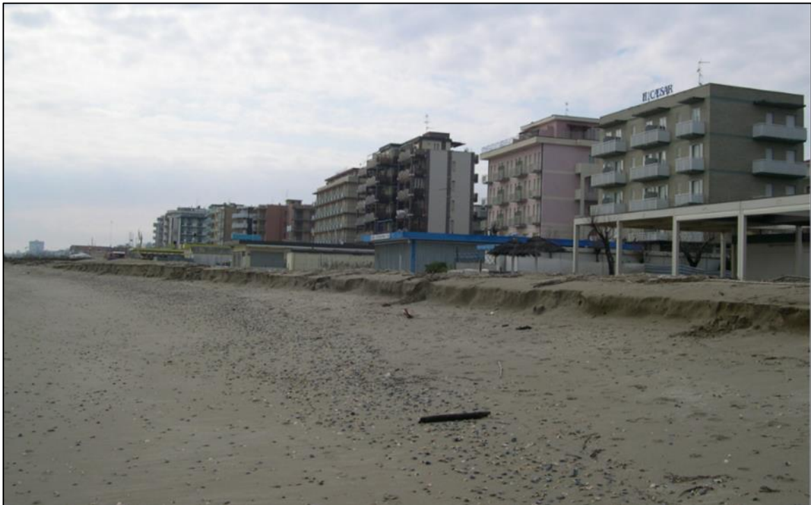
Figura I.2.2-7: abbassamento del piano di spiaggia e creazione di scarpata erosionale (Lido di Savio)
