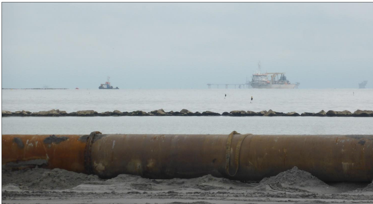
Figura I.4.2-1: tubazioni posizionate lungo il litorale durante le operazioni di ripascimento per la distribuzione del materiale estratto dai giacimenti sottomarini
