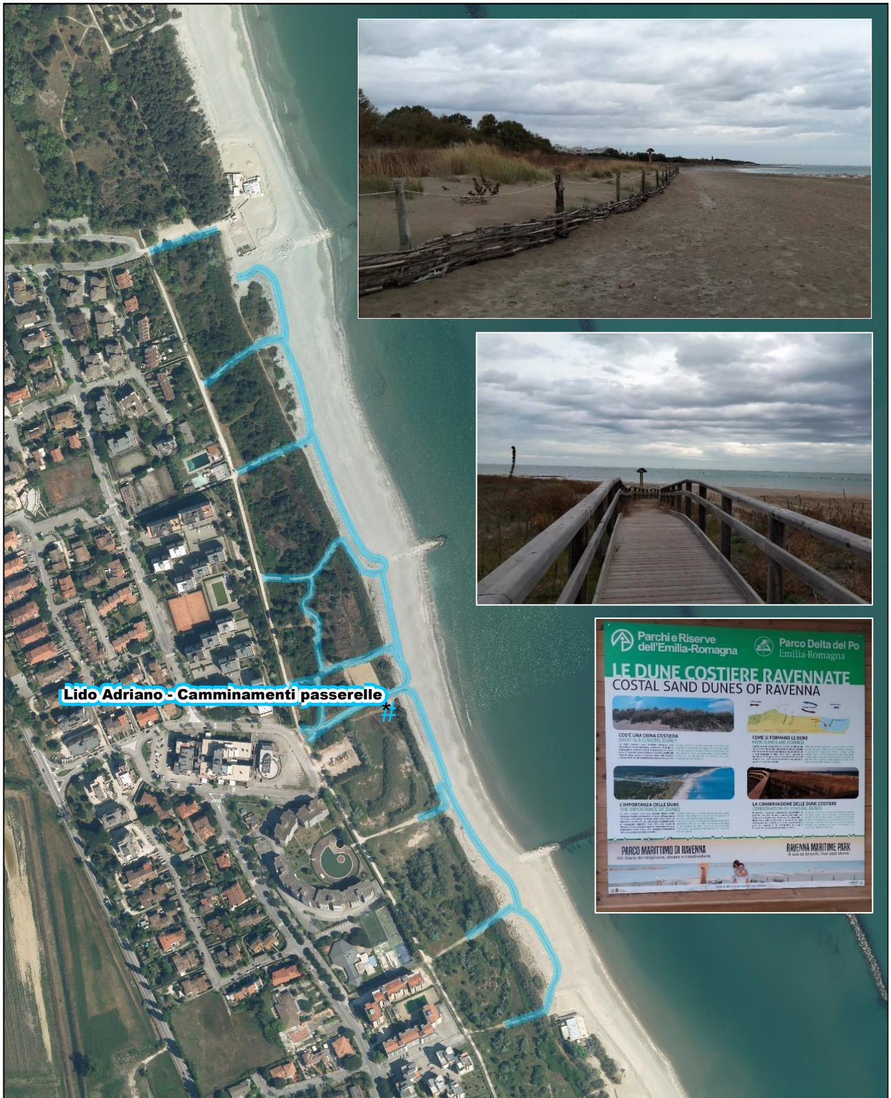
Figura I.5.1-8: Ubicazione e dettagli intervento di protezione a Lido Adriano
