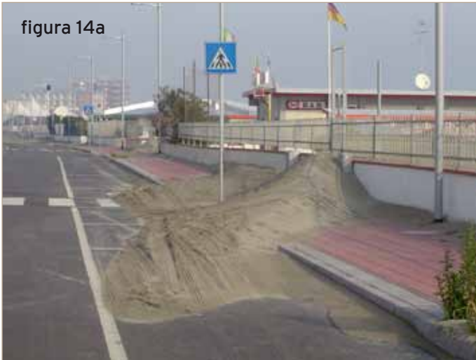
figura 14 A: effetti negativi dovuti all'assenza di barriere frangivento: la sabbia invade la sede stradale. B: la messa in opera di barriere frangivento permette di intrappolare la sabbia e ridurre le perdite.
