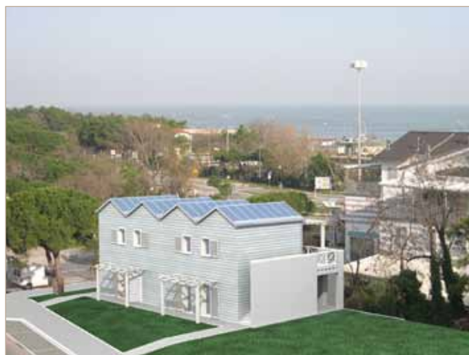
figura 10 esempi di progetti finanziati in ambito GIZC. In alto: stazione di monitoraggio nella Valle Fattibello (Ferrara). In basso: riqualificazione di un edificio pubblico a Punta Marina (Ravenna)
