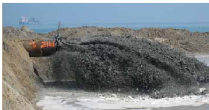
figura 24 Sversamento di sabbie sottomarine durante il secondo ripascimento del 2007
