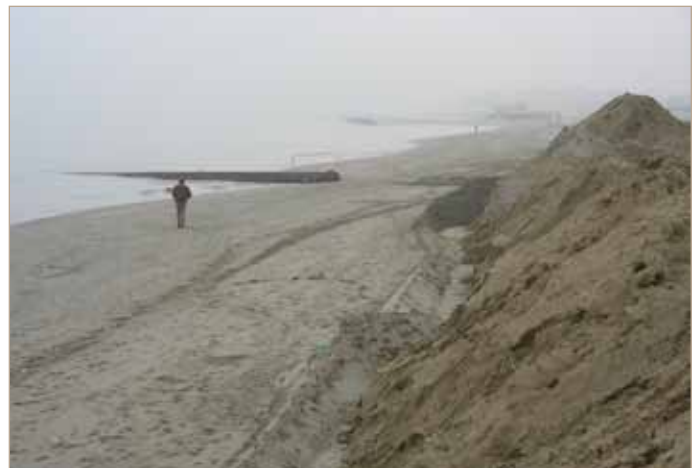
figura 26 Riccione sud: il cumulo di sabbia proveniente dallo scavo di opere edili, primavera 2007
