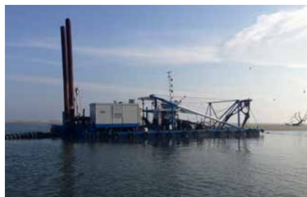
Figura 33 Draga in azione sullo Scanno di Goro.
