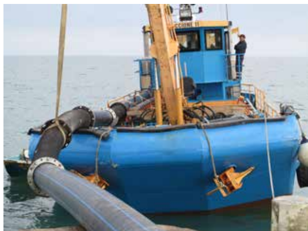
Figura 29 Innesso del tubo rifluente della draga con il sabbiodotto di Riccione
