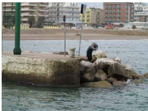
Figura 30 pozzetto di innesto della tubazione del sabbiodotto sul molo di ponente del porto canale di Riccione.
