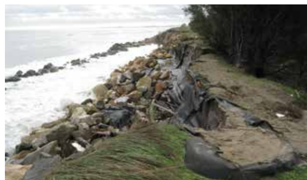
Figura 15 Erosione difesa radente alla pineta di Volano nord.
