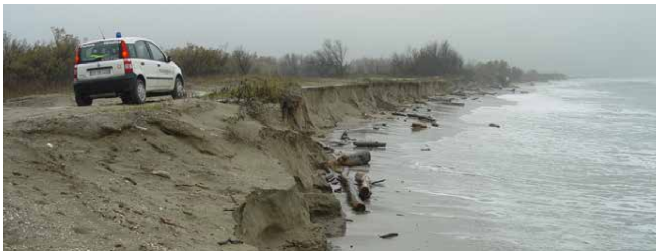
Figura 10 Scarpata di erosione di una spiaggia durante un evento di mareggiata.
