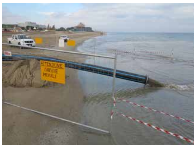
Figura 31 Sversamento della miscela acqua-sabbia dragata dal porto canale sulla spiaggia di Riccione Sud.
