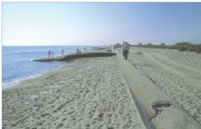
Fig. 2 - Tubi Longard posti a difesa del litorale in prossimità del Lido di Spina
