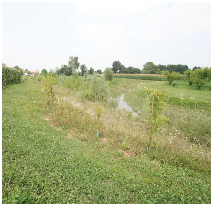
Figura 63 Creazione di una golena allagabile tramite sbancamento di una sponda; la nuova area allagabile, creata con finalità idrauliche, permette la messa a dimora di filari arboreo-arbustivi senza che questi aggravino le condizioni di rischio idraulico. (Foto: Consorzio di bonifica Acque Risorgive)
