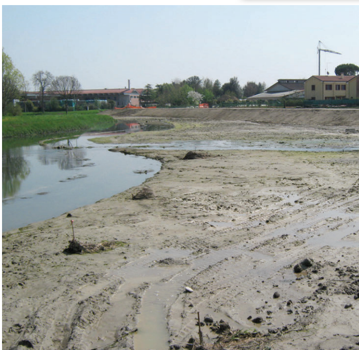
Figura 63 Creazione di una golena allagabile tramite sbancamento di una sponda; la nuova area allagabile, creata con finalità idrauliche, permette la messa a dimora di filari arboreo-arbustivi senza che questi aggravino le condizioni di rischio idraulico. (Foto: Consorzio di bonifica Acque Risorgive)
