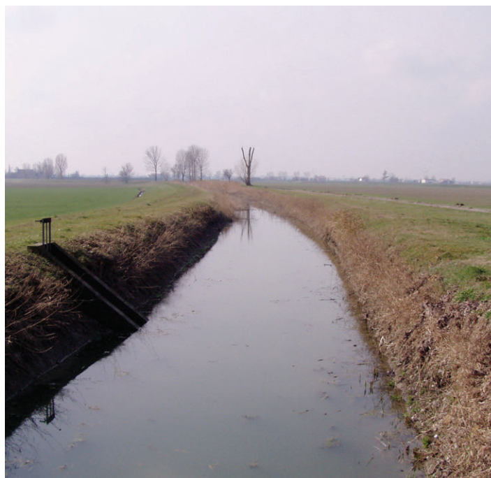
Figura 74 Il canale nel 2009, a 5 anni dalla fine dei lavori; l'inerbimento delle sponde con georete in cocco e talee di salice si è sviluppato e i deflettori, sullo sfondo nella foto, svolgono la loro funzione di diversificazione morfologica dell'alveo. (Foto: Marco Monaci)
