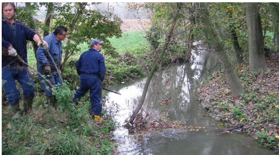
Figura 103 Intervento di manutenzione manuale della vegetazione. (Foto: Consorzio di bonifica Acque Risorgive)
