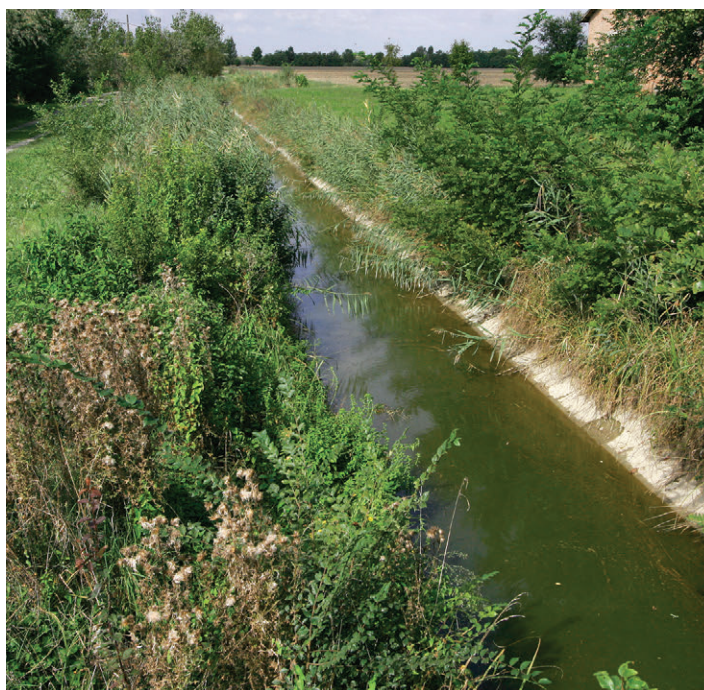
Figura 101 Esempio di posticipo del taglio della vegetazione in alveo nel periodo autunnale (Fosso Nord). (Foto: Consorzio della bonifica Burana)
