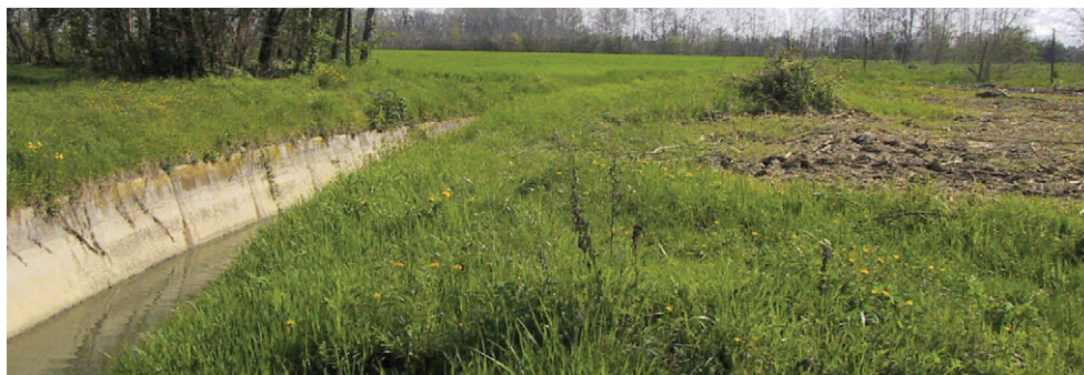
Figura 23 Creazione di una fascia di mobilità mediante interventi fisici sul canale.
