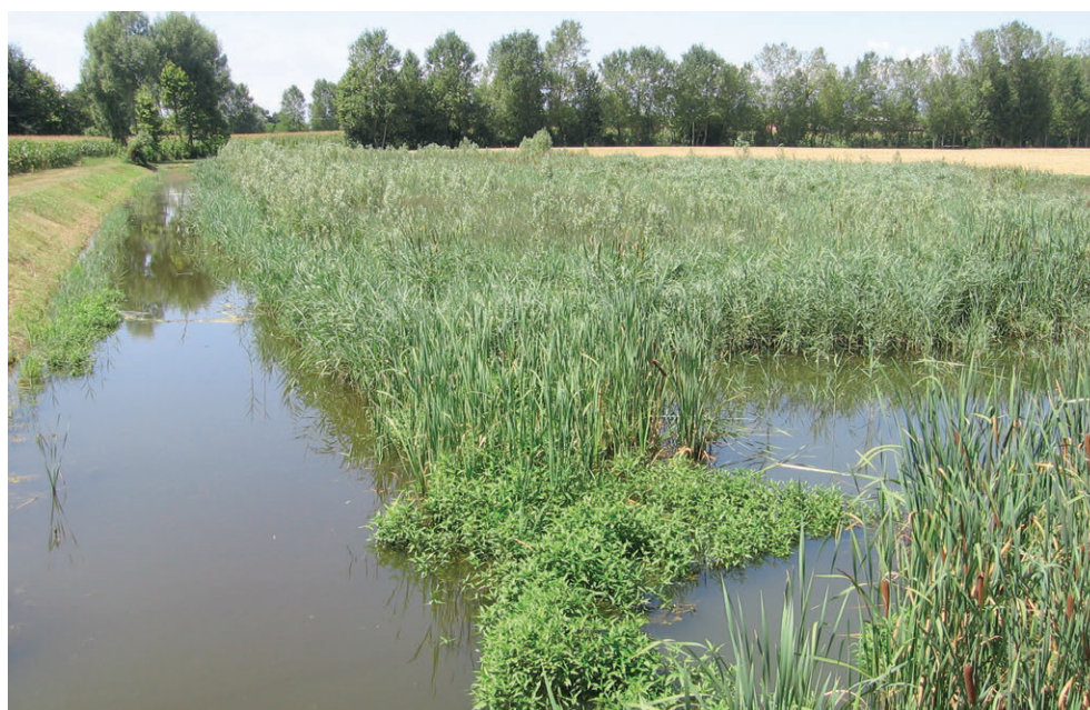
Figura 110 Esempio di zona umida in alveo con finalità secondaria naturalistica; in evidenza sulla sinistra il canale di corrente preferenziale, mantenuto aperto grazie agli interventi di gestione della vegetazione eseguiti dalla sponda limitrofa. (Foto: Consorzio di bonifica Acque Risorgive)
