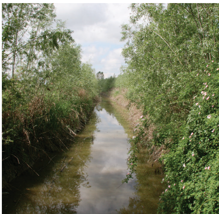
Figura 74 Il canale nel 2009, a 5 anni dalla fine dei lavori; l'inerbimento delle sponde con georete in cocco e talee di salice si è sviluppato e i deflettori, sullo sfondo nella foto, svolgono la loro funzione di diversificazione morfologica dell'alveo. (Foto: Marco Monaci)
