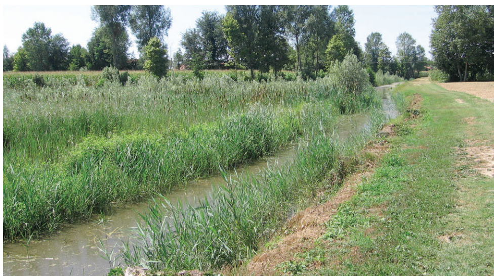
Figura 105 Presenza di vegetazione arbustiva su una piccola area golenale (a sinistra nella foto); la manutenzione della vegetazione erbacea è in questo caso effettuata sulla parte sommitale delle scarpate in entrambe le sponde, mentre quella della vegetazione acquatica è effettuata operando dalla sponda opposta rispetto a quella con vegetazione arbustiva, che non viene tagliata. (Foto: Consorzio di Bonifica Acque Risorgive)
