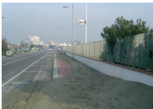
Figura 17a e 17b. Perdite per erosione eolica
