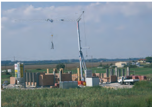
Figura 3. Costruzione del centro di monitoraggio ambientale a Goro (FE)
