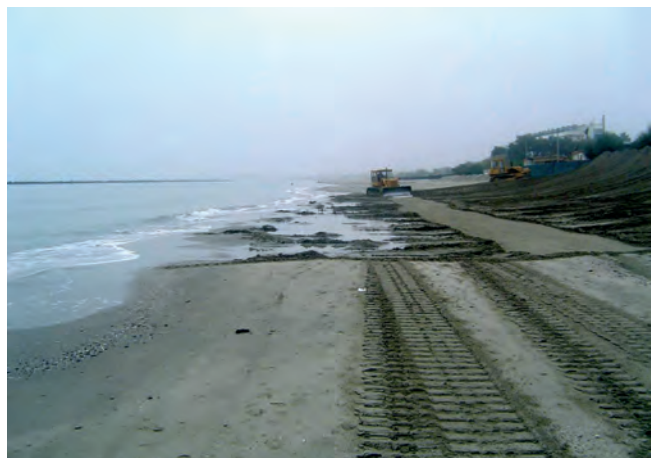
Figura 15. Argine invernale in costruzione con modalità non corretta
