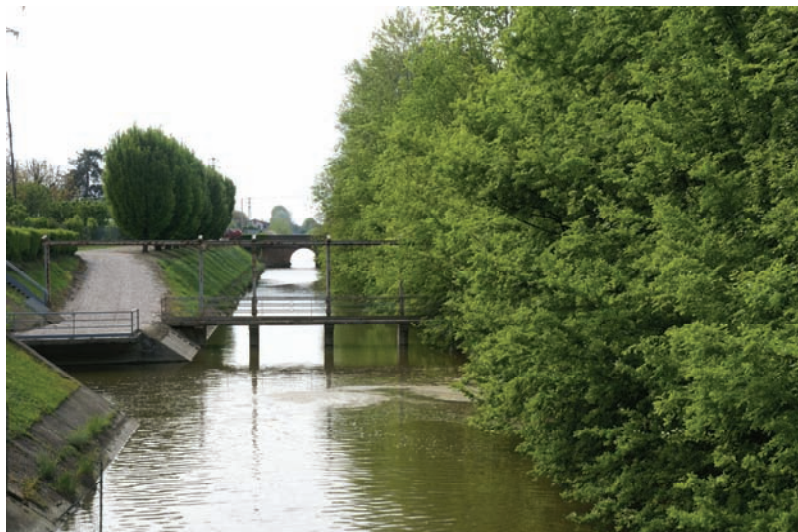
Figura 5 Canale con vegetazione arborea e arbustiva su una sponda.
