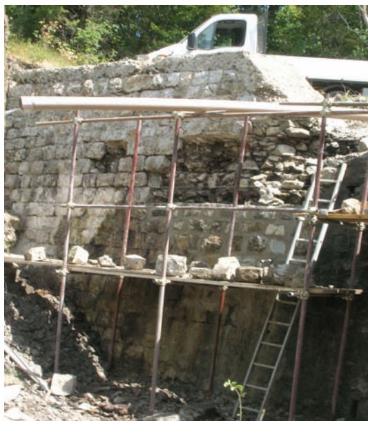
Figura 15 lavori di manutenzione ordinaria su una briglia
