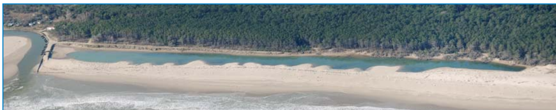
Immagine da bassa quota dell’area di foce Bevano. A sinistra la nuova foce, a destra la chiusura della vecchia foce con la ricostruzione della duna (foto G.Gabbianelli)
