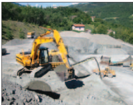
Foto 28 – Fase di scavo
