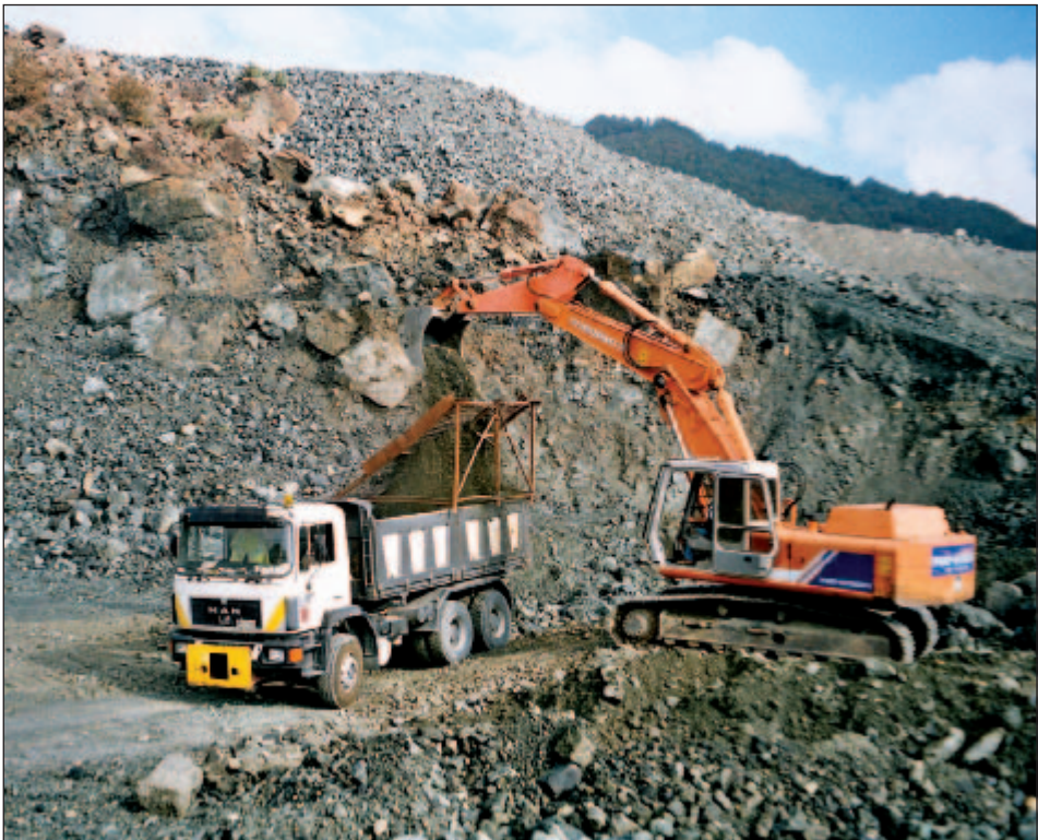
Foto 29 – Fase di carico (C. Pedroni)
