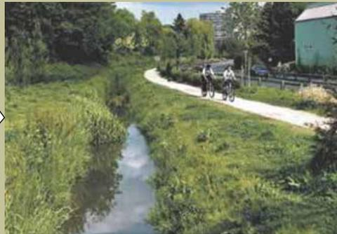
Figura 46 – Esempio di rimozione del tombinamento di due tratti urbani del fiume Bièvre, corso d'acqua di risorgiva che confluisce nella Senna a Parigi (Francia).
