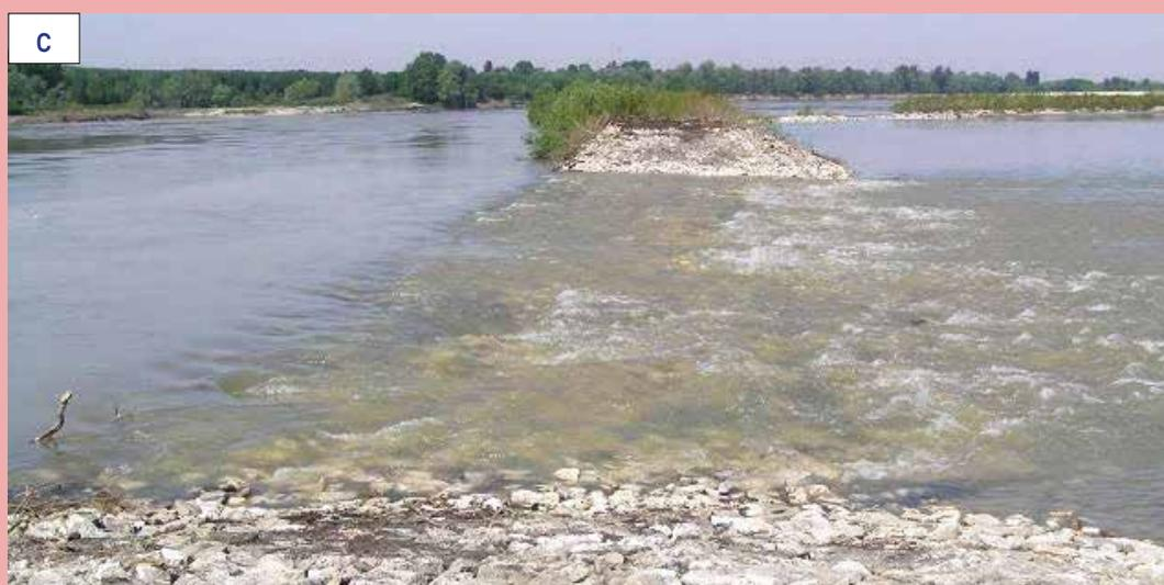
Figura 27 - a) esempio di abbassamento di un pennello lungo il fiume Po a Casalmaggiore. Il pennello evidenziato in figura (in azzurro) era parzialmente dissestato; l'intervento realizzato (tratto di 200 m, in rosso) lo ha consolidato alla quota di sfioro per una portata di 800 m<sup>3</sup>/s, permettendo così la riattivazione della lanca retrostante, che è stata facilitata tramite un rimodellamento del tratto terminale in corrispondenza dell'immissione nell'alveo del Po.
