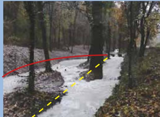
Figura 10 - Esempio di creazione di piana inondabile in un corso d'acqua non arginato mediante abbassamento del piano campagna (rio Enzola, Provincia di Reggio Emilia).
