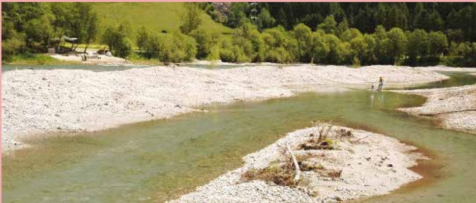
Figura 22 – Esempio di rimozione di difese spondali e allargamento di sezione.
