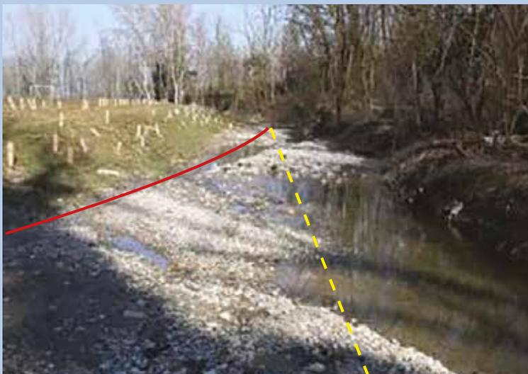
Figura 12 - Esempio di creazione di piana inondabile in un corso d'acqua non arginato mediante abbassamento del piano campagna (rio Lavezza, Comune di Albinea in Provincia di Reggio Emilia).
