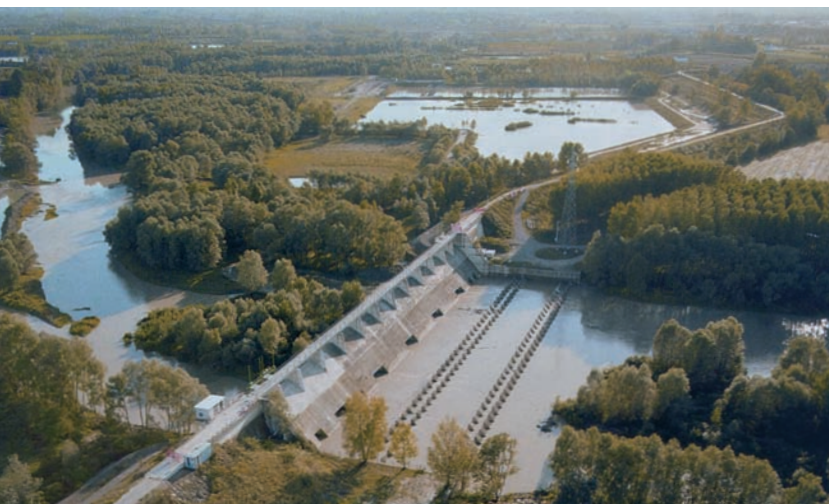
Cassa di espansione del fiume Panaro, Comuni di Modena e S.Cesario (Mo). Recupero con funzione idraulica e naturalistica
