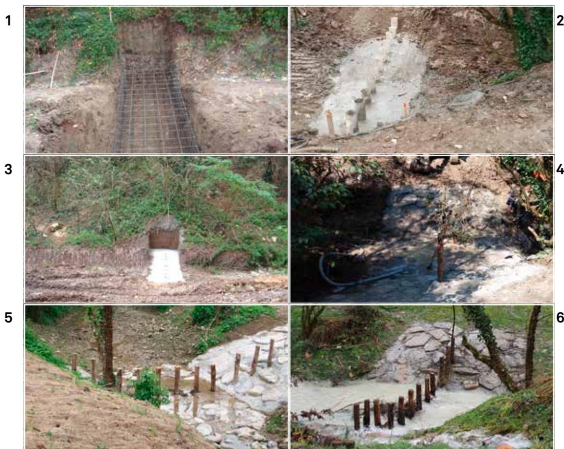
Figura 17 – Sequenza delle fasi di realizzazione di una briglia selettiva sul rio Bertolini.
