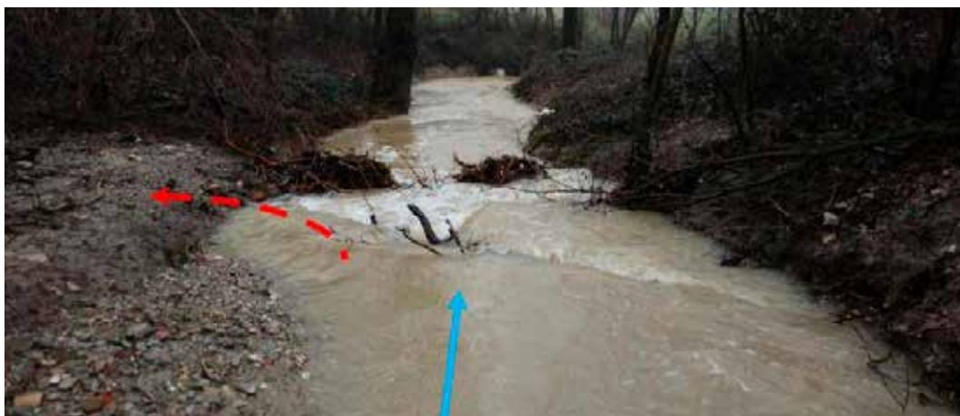
Figura 13 –Intervento di realizzazione di un salto naturaliforme realizzato sul Rio Lavezza. In alto si nota l'intervento appena realizzato, che si inserisce in un alveo dominato dalla presenza prevalente di riffle come unità morfologiche. In basso si nota il come l'intervento, in fase di morbida, tenda a favorire la riconnessione idrologica e morfologica della piana inondabile presente in sponda sinistra.
