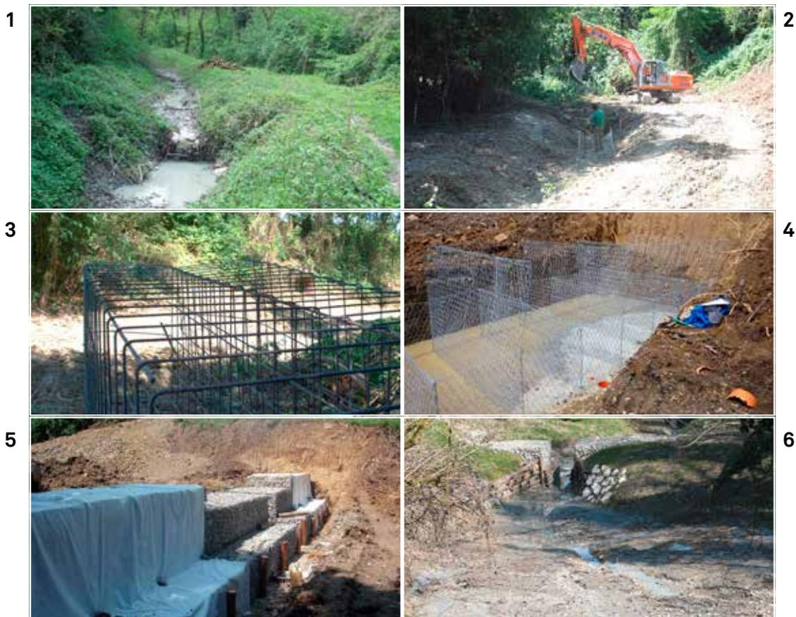
Figura 10 – Sequenza delle fasi di realizzazione del restringimento di sezione in pietrame in corrispondenza di un intervento di allargamento e ricreazione di piana inondabile sul Rio Bianello.
