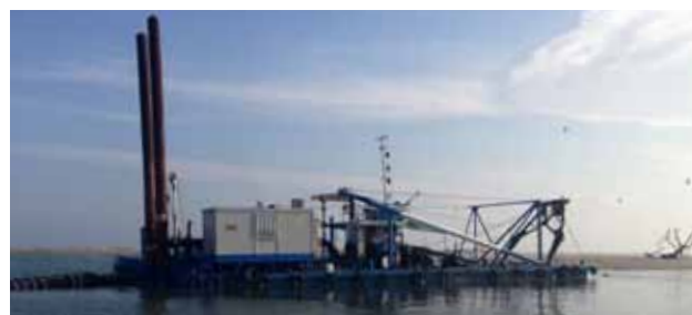
Figure 33 Dredge working on Scanno di Goro.
