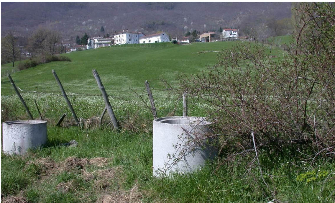
Alfero: inclinometri da automatizzare
