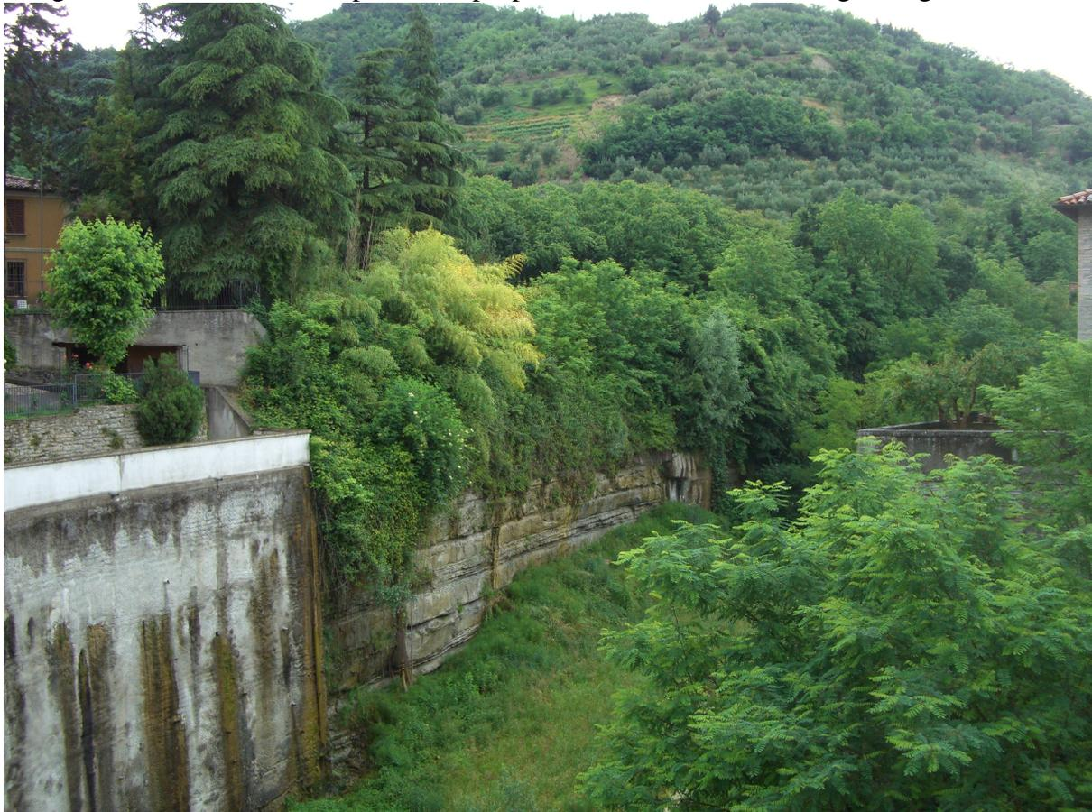
Rio Bagno versante destro\_Muro in “Spriz-Beton”- Previsto pulizia muro.
