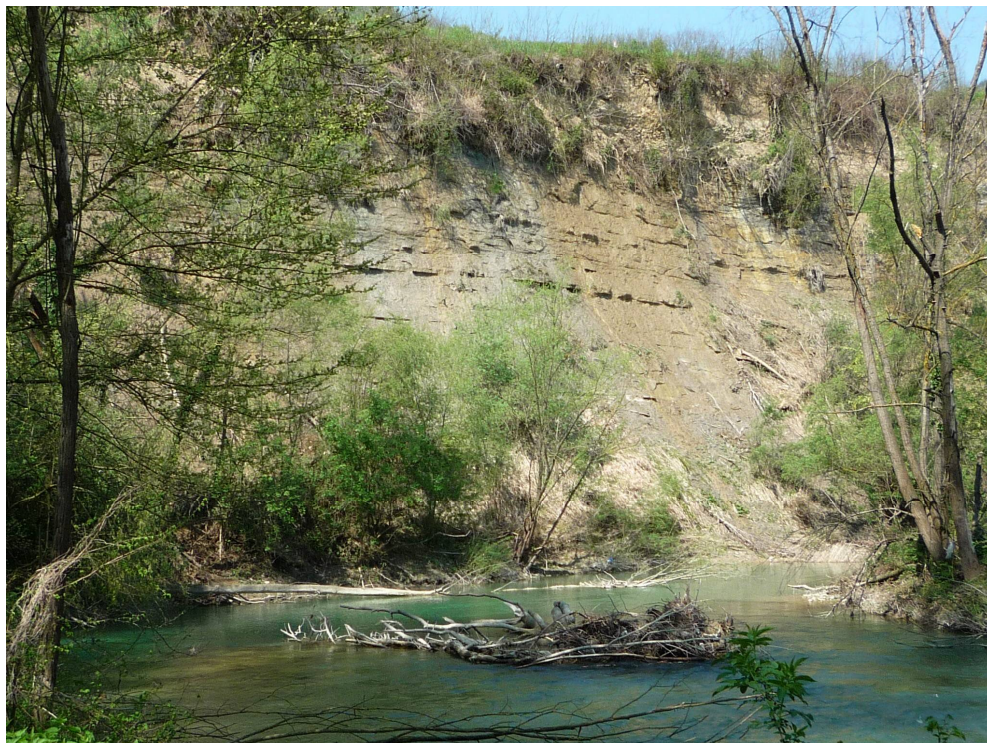
Torrente Ibola a monte dell'abitato di Modigliana Necessaria manutenzione diffusa
