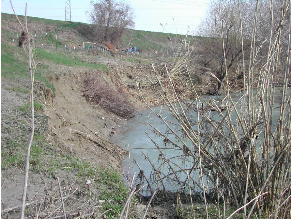
Fiume Lamone zone arginate a valle di Faenza Tipologia di frane spondali da riprofilare
