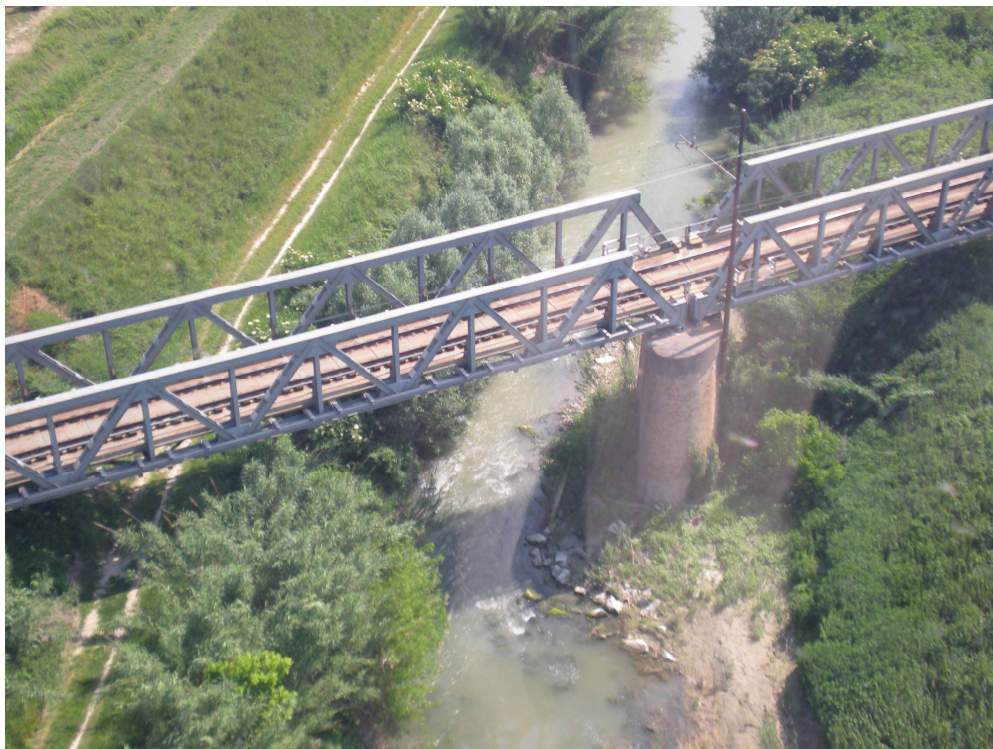
Fiume Lamone ponte ferroviario a monte della località Russi L'alveo fluviale in corrispondenza dei ponti deve essere attentamente mantenuto
