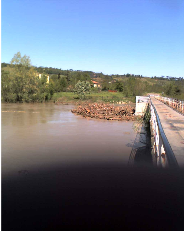
Fiume Lamone alla Chiusa di Errano Esempio di depositi alluvionali da rimuovere
