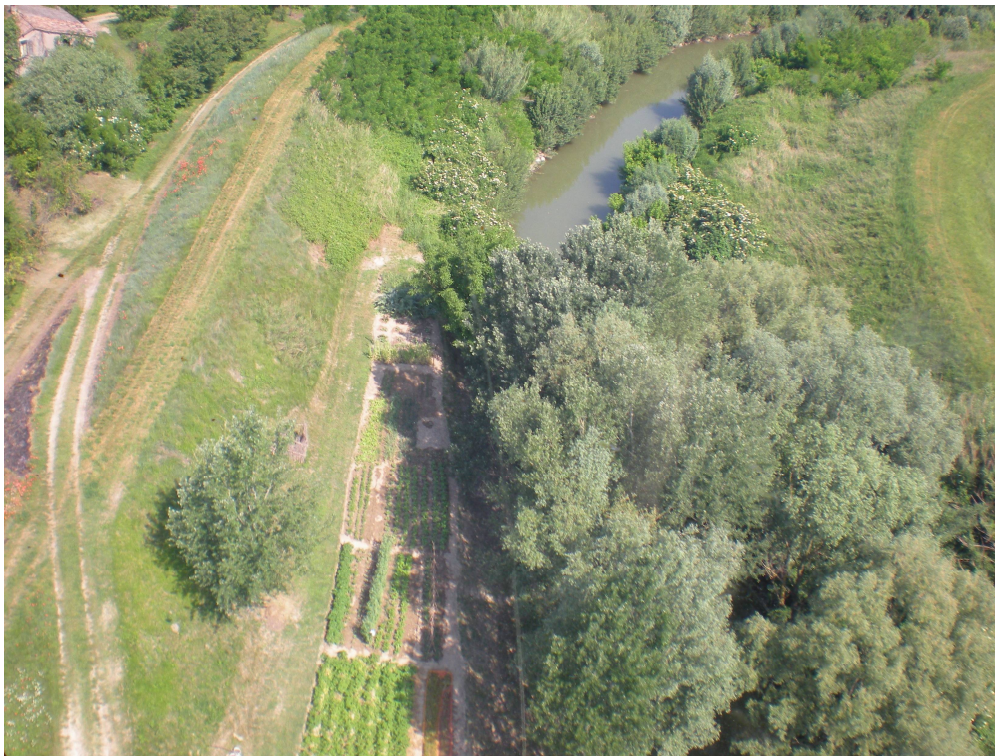
Fiume Lamone tra Faenza e Russi L'immagine evidenzia la differente condizione di alveo recentemente mantenuto, parte alta, rispetto alla parte bassa dove occorre procedere a taglio selettivo di vegetazione arborea
