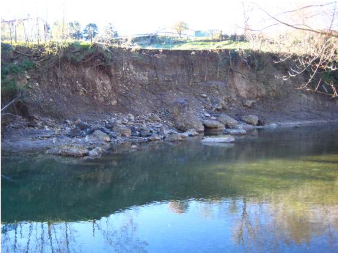
Particolari: Scarpate fluviale franata dall'erosione delle piene
