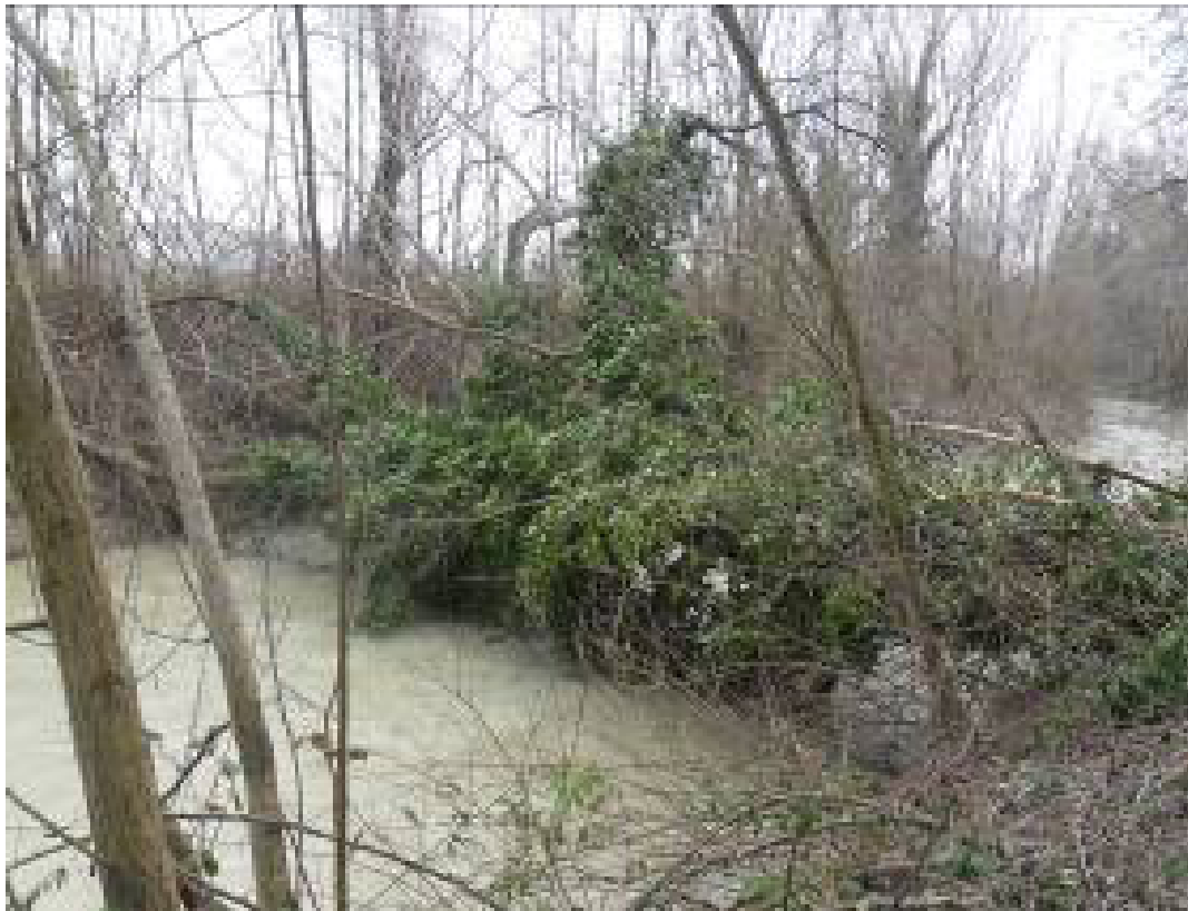
Particolare: Difesa spondale in pali di castagno distrutta dalle piene
