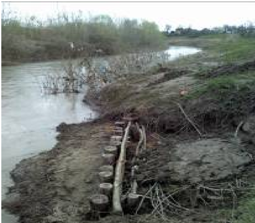
Particolare: Difesa spondale in pali di castagno distrutta dalle piene
