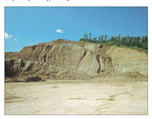
Rinfianco della scarpata con materiale di riporto adeguato, ben compattato in spessori sottili: tecnica meno raccomandabile per la maggiore instabilità dei rilevati; da utilizzare solo in condizioni limite, altrimenti non risolvibili (ad es. vecchi scavi da risistemare).
