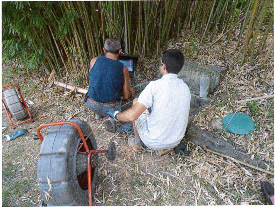
Foto 1 – Indagine delle rotture della condotta di scarico del pozzo di drenaggio tramite video ispezione
