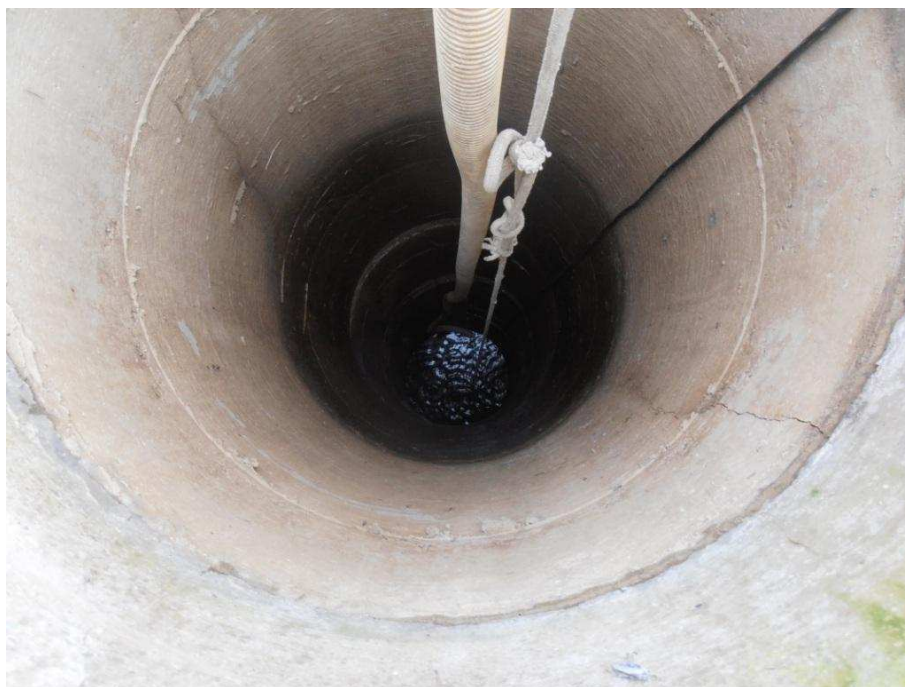
Foto 3 – Vista del pozzo di raccolta delle acque drenate, della profondità di -7 m dal p.c., realizzato dal Consorzio di Bonifica nel 1971. In data 10/03/2015 si è proceduto con l'abbattimento della falda freatica con emungimento forzato della acqua.
