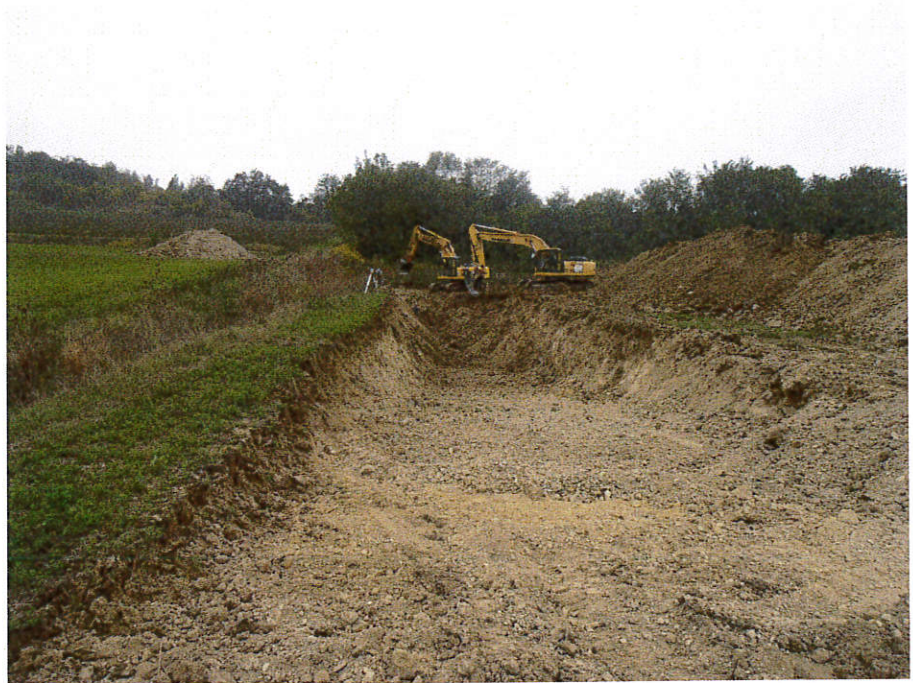
Foto 3 – Vista dei lavori di pre-scavo a larga sezione eseguiti il 5 ed il 8 ottobre per la ricostruzione dello scarico del pozzo di drenaggio, con messa in opera di una nuova condotta PEAD Ø90mm PN16.
