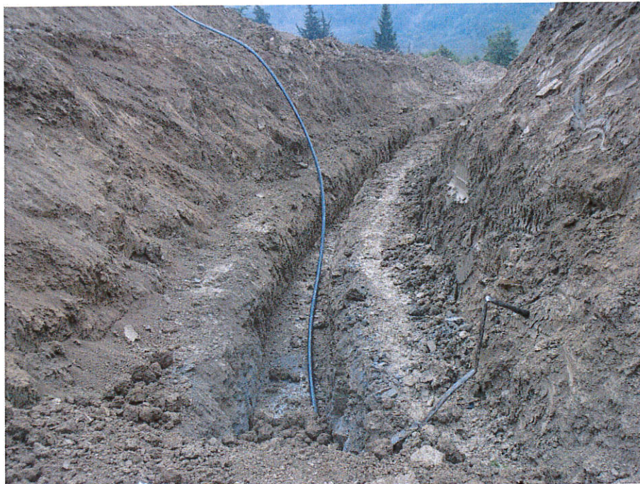
Foto 5 – Scavo a sezione obbligata per la posa della nuova condotta PEAD Ø90mm PN16 di scarico del pozzo drenante. A destra della trincea di scavo si nota un frammento della precedente condotta di scarico in ferro Ø63mm. Alla nuova condotta, nello scavo obbligato, è stato affiancato un drenaggio con tessuto Enkadrain e tubo microfessurato.
