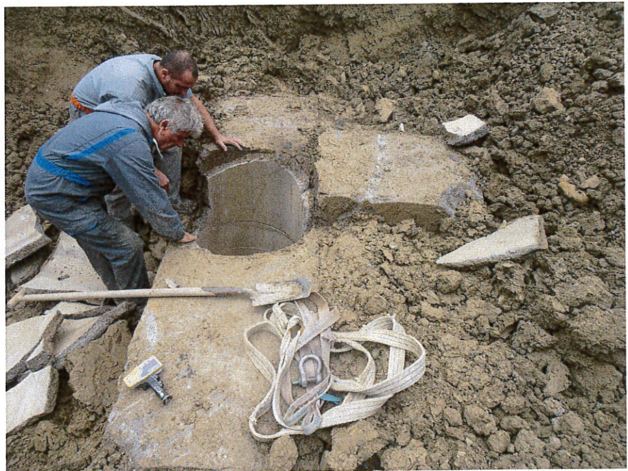
Foto 4 – Smontaggio manuale dei frammenti degli elementi in cls ad anello costituenti il pozzo e fratturati e deformati in conseguenza dell'attivazione della frana in parola.
