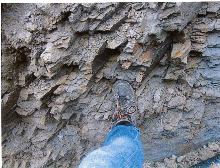
Foto 6 – Particolare del substrato roccioso fratturato ritrovato ai alti dello scavo a sezione obbligata per la posa della nuova condotta. La presenza di ossidazioni e mineralizzazioni nelle fratture pervasive del substrato attraversato con lo scavo è stata associata ad una elevata circolazione freatica nella porzione sommitale del substrato
