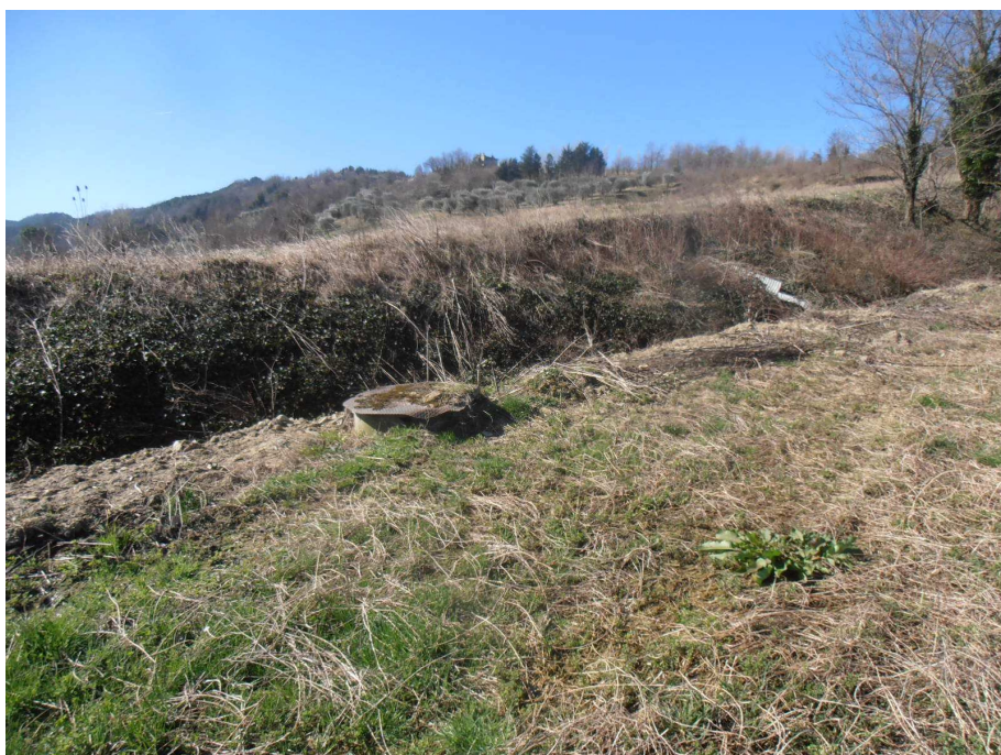
Foto 2 – Vista del pozzo di raccolta delle acque drenate, della profondità di -7 m dal p.c., realizzato dal Consorzio di Bonifica nel 1971. In data 06/03/2015 il livello freatico all'interno del pozzo risultava pari alla quota del piano campagna.
