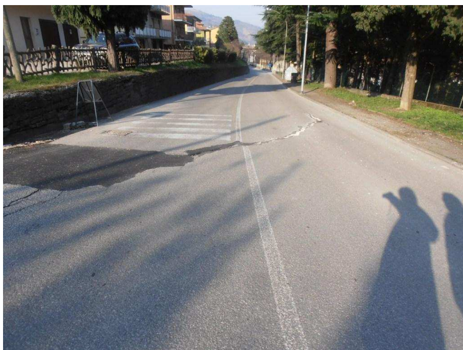
Foto 6 – Vista delle fratture della carreggiata della SP 20 in corrispondenza con l'incrocio con Via dei Frati.
