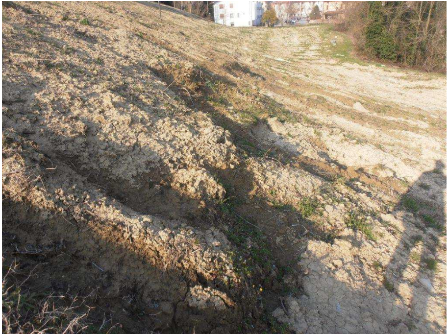
Foto 15 – Vista delle emergenze idriche rilevate al piede del versante in loc. Vico, a valle della SP 20.
