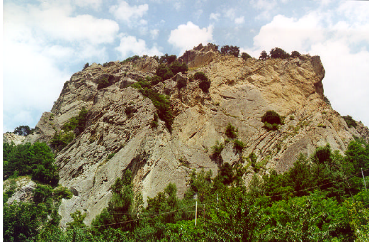
Foto 1: parete rocciosa soggetta a crolli che incombe sull'abitato di Perticara
