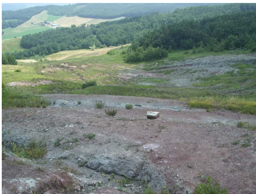
Panoramica dall'alto che evidenzia gli accumuli di materiale verso valle
