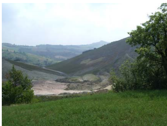
Panoramica dell'area di cava da ovest
