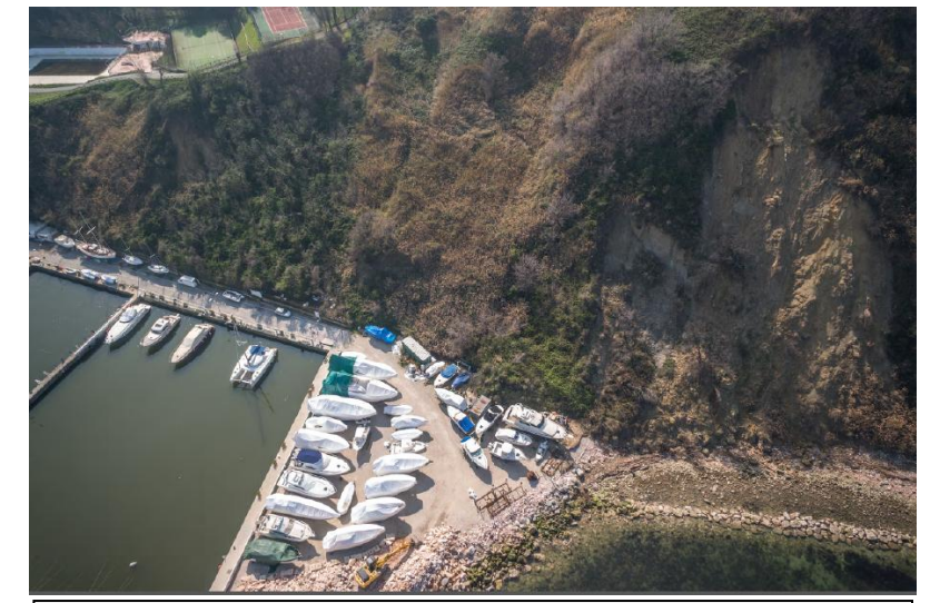
Fenomeni franosi che minacciano la zona portuale di Vallugola - Comune di Gabicce riprese UAV sorvolare.it - 2014
