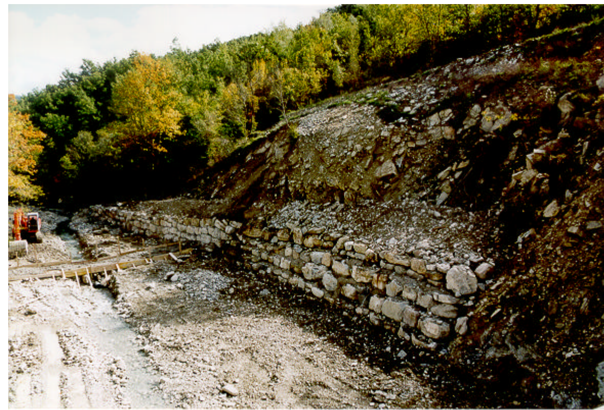
Foto 3: interventi in fase di realizzazione lungo il F. Marecchia
