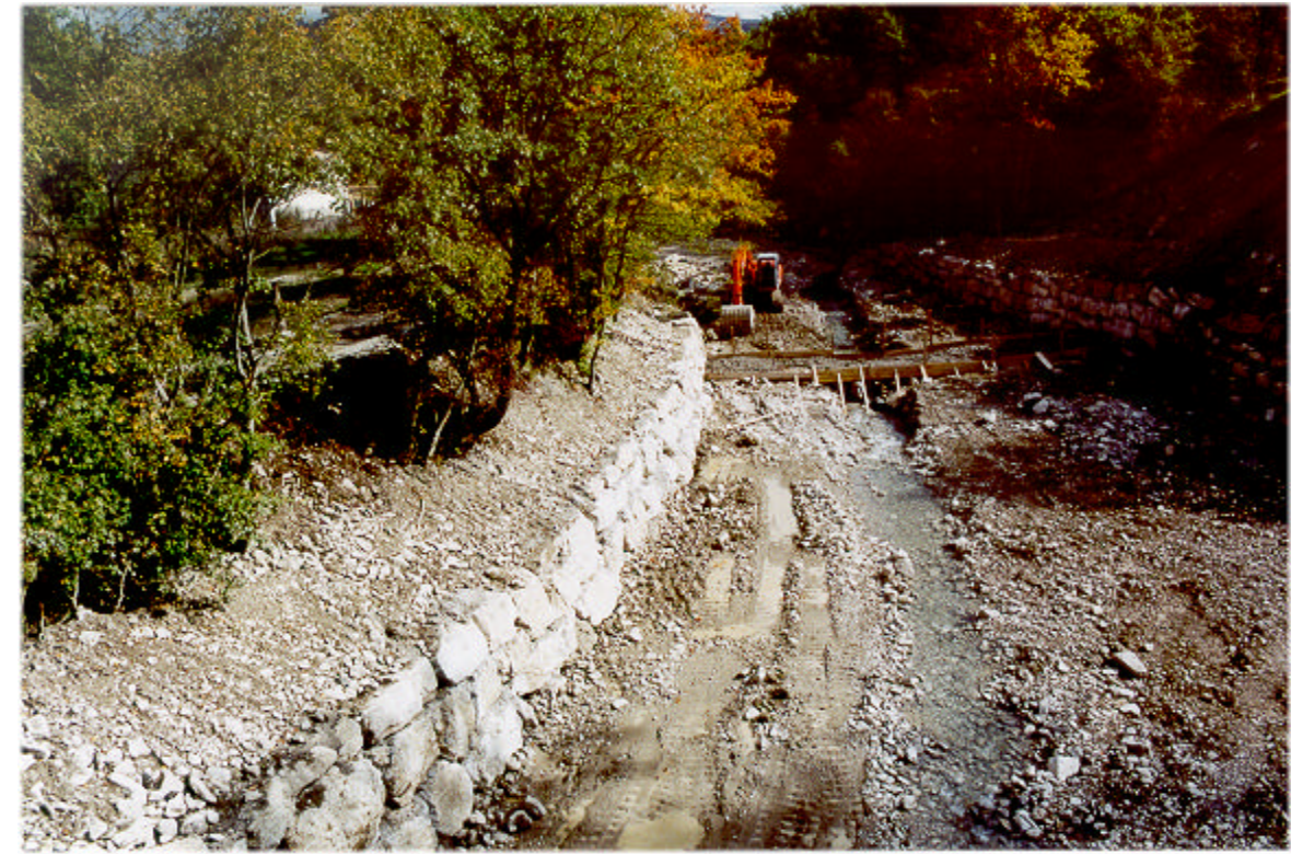
Foto 2: interventi in fase di realizzazione lungo il F. Marecchia
