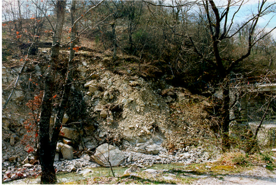
Foto 1: scivolamento di detrito che coinvolge l'alveo del F. Marecchia
