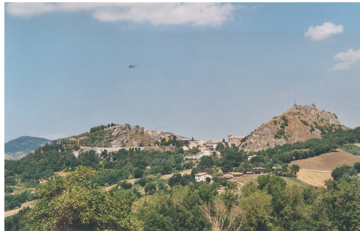
Foto 2: panoramica del versante in frana a sud del centro storico
