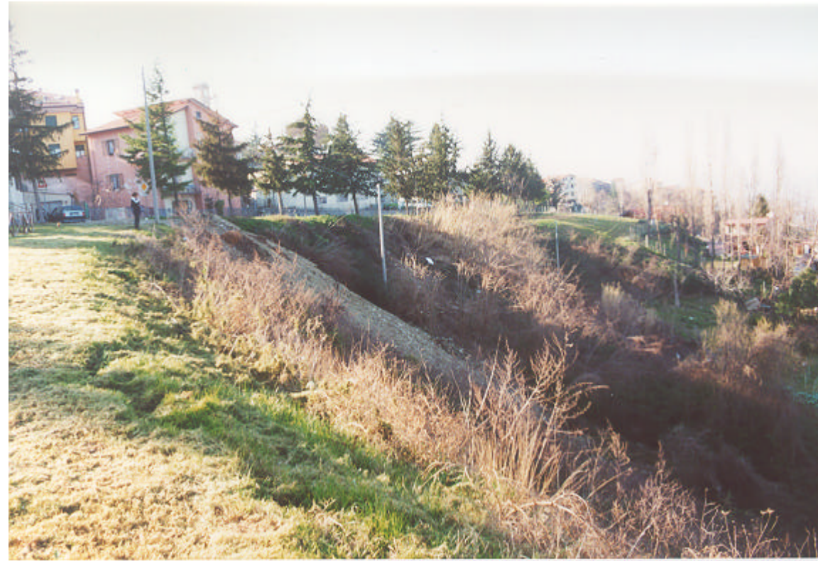
Foto 1: riattivazioni recenti nella zona di corona del dissesto
