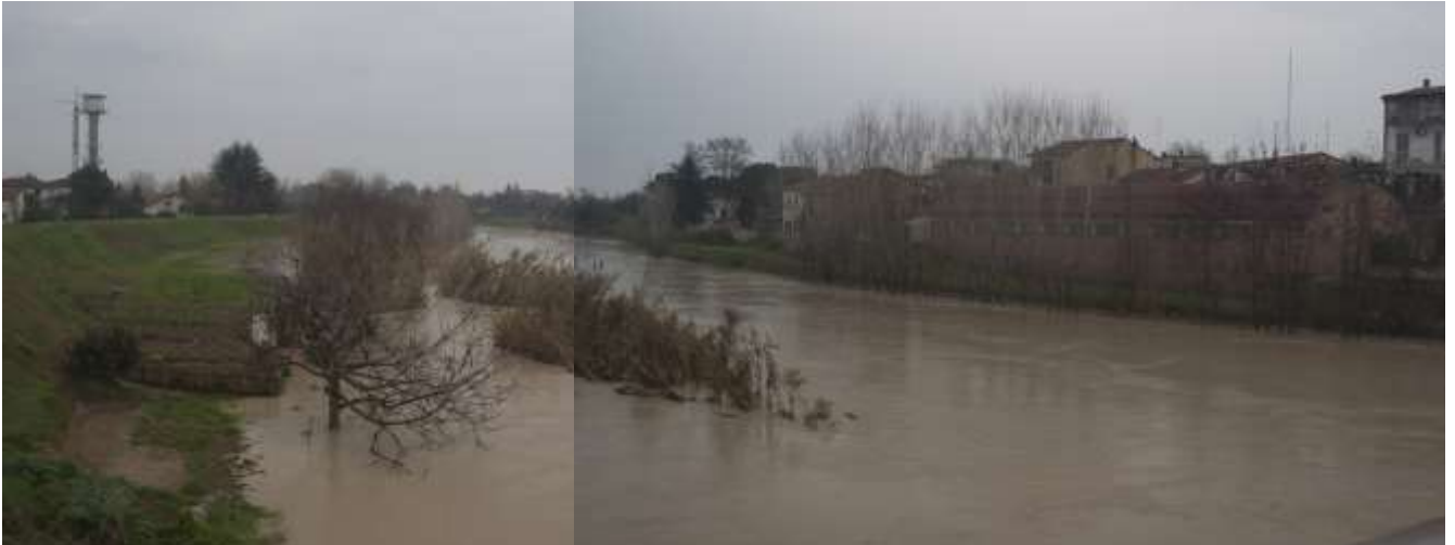
Figura 1 – Piena del fiume Montone: Foto scattata dal ponte della SS. 9 in occasione dell'evento di piena del 4-5 marzo 2014, poco prima dell'inizio dell'incontro.
