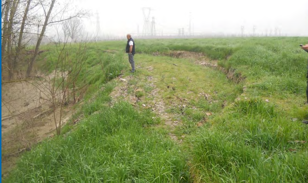
Foto 3 Il terreno sulle sponde a causa della tracimazione e del prolungato imbibimento tende a franare
