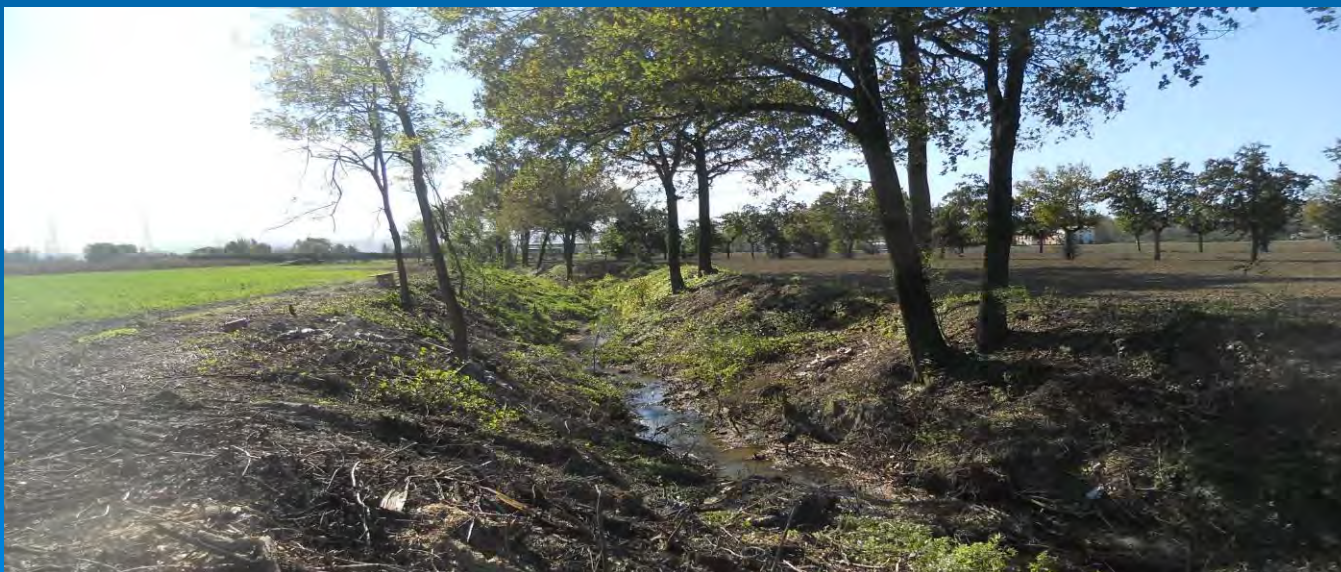
DOPO INTERVENTO Torrente Gherbella.
