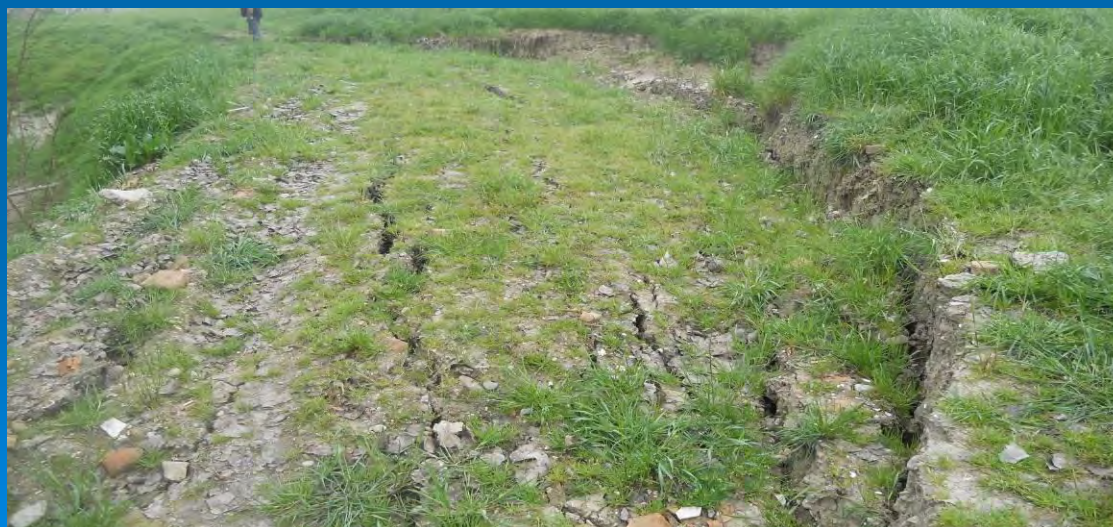
Foto 3 Il terreno sulle sponde a causa della tracimazione e del prolungato imbibimento tende a franare
