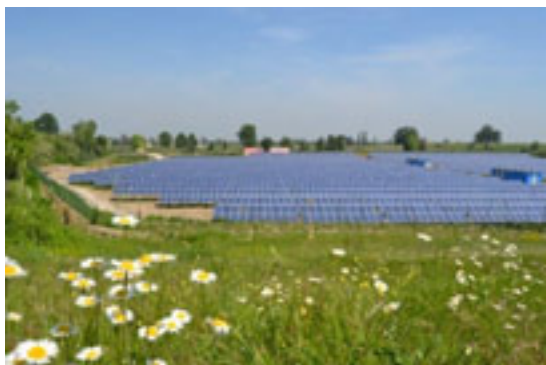
Impianti Fotovoltaici – Cava Ca Tripoli
