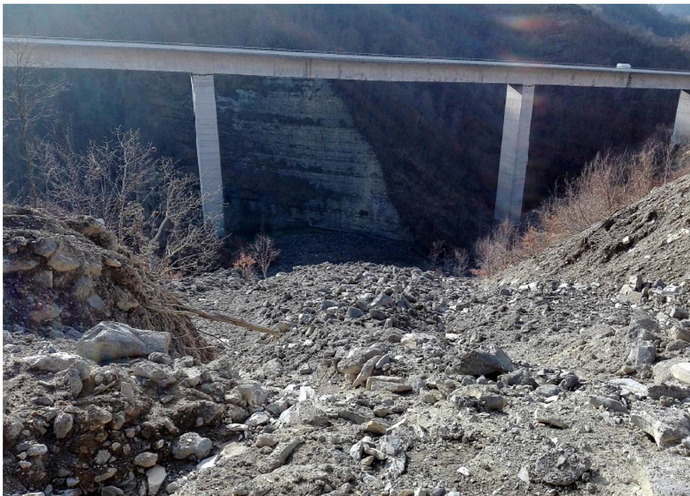
Figura 21 - Frana sulla SP 137, Verghereto (FC): la parte bassa della frana costituita da detrito roccioso incanalato trasportato dalla colata detritica che si è sviluppata a valle dello scivolamento planare (foto della Provincia di Forlì- Cesena).
