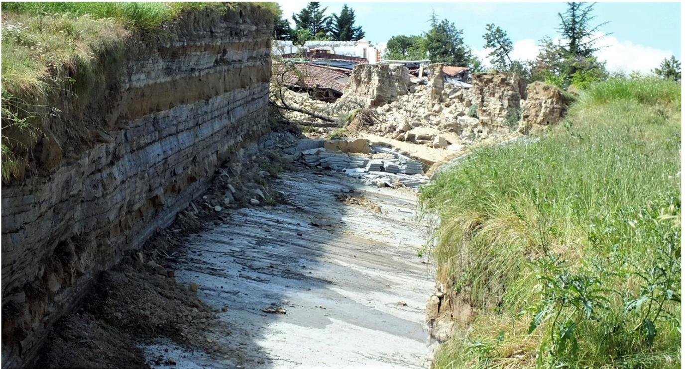
Figura 22 - Frana di Via Raggio, Borgo Tossignano (BO): esposizione del piano di scorrimento dello scivolamento planare tipico della formazione Marnoso arenacea romagnola, affiorante a sinistra della foto. Sullo sfondo l'edificio distrutto.
