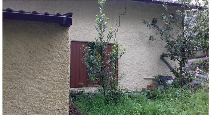
Figura 26 - Frana in località Tramonte (Camugnano, BO) che ha interessato circa 0,5 Ha di terreno e lesionato due edifici (foto del Servizio d'Area Reno e Po di Volano).
