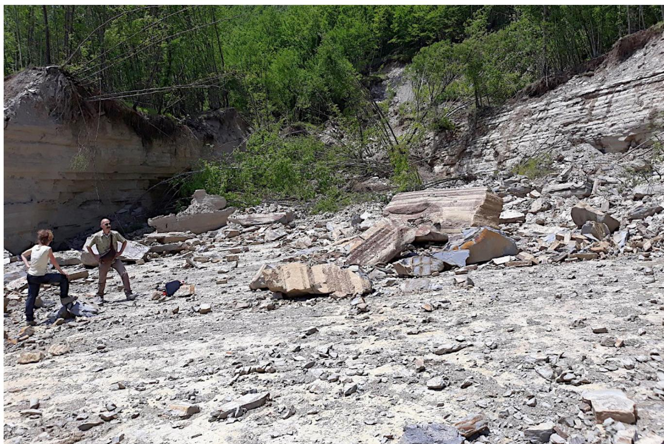
Figura 20 - Frana sulla SP 137, Verghereto (FC): la parte alta della frana con esposizione del piano di scivolamento planare. Nella parte sinistra della foto è visibile parte della massa rocciosa dislocata (foto da sopralluogo di UNIBO - Dipartimento BiGeA).
