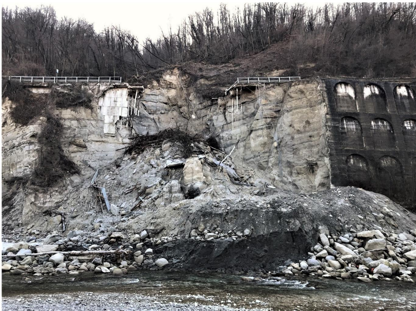
Figura 11 - Visione frontale della frana che ha interrotto la SP 325 della Val di Setta il 6 aprile 2019. La foto è stata scattata il 23 gennaio 2020 - Servizio Geologico, Sismico e dei Suoli. In primo piano sono visibili le argille nerastre estruse lungo un piano di scorrimento. Rispetto alla foto precedente a distanza di circa nove mesi si nota anche il notevole abbassamento subito dal prisma, rimasto sospeso in concomitanza dell'inizio del movimento.
