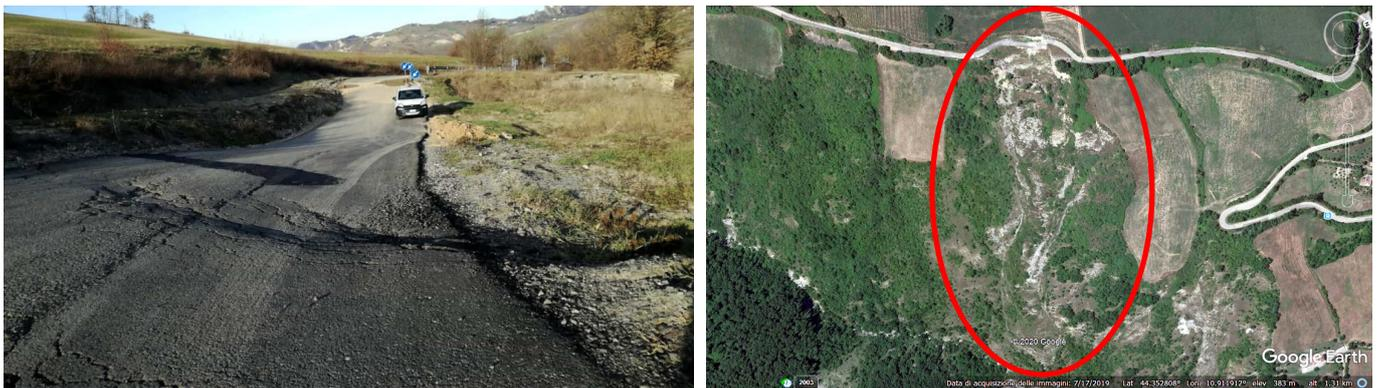
Figura 8 - La SP 26 “due querce” interrotta nei pressi della località Castagneto (Pavullo, MO). A sinistra foto tratta da Modenatoday.it del 13/02/2019. A destra immagine di Google Earth del 17/07/2019, che evidenzia l'estensione della frana a valle della strada.
