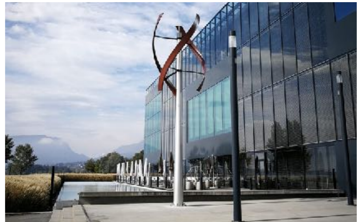
Produzione energetica da impianto eolico
