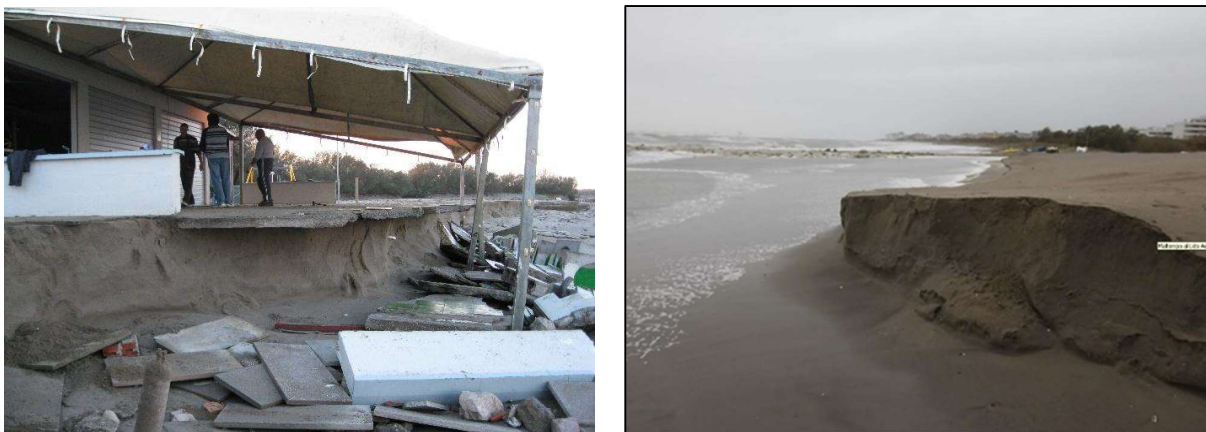
Figura A.2.5-1. Esempi di erosione costiera nei lidi ferraresi
