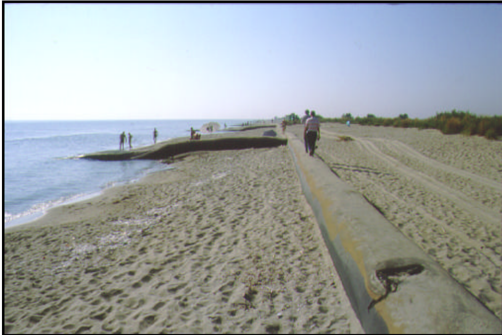
Figura 2 - Tubi Longard posti a difesa del litorale in prossimità del Lido di Spina
