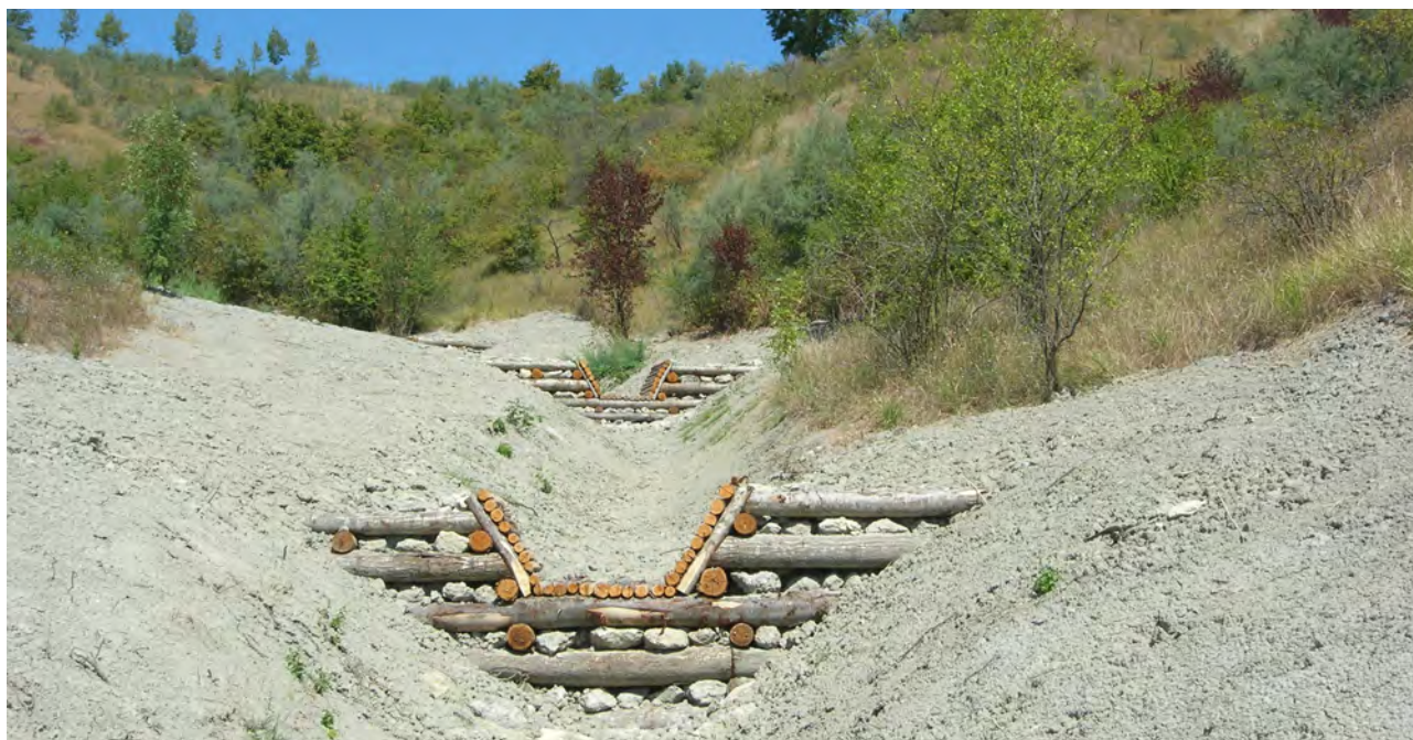
Figura 9 Opere di ingegneria naturalistica per il controllo dell'erosione superficiale, Parco museo geologico del Monticino, Brisighella (RA)
