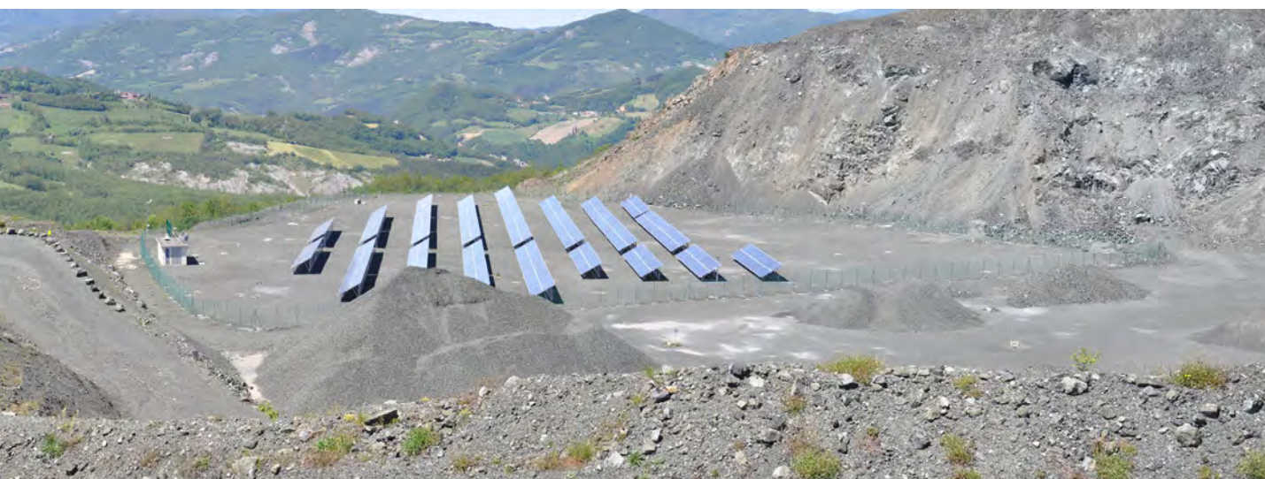
Figura 1 Monte Zirone (Terenzo, Parma). Esempio di recupero tecnologico (Impianto fotovoltaico)
