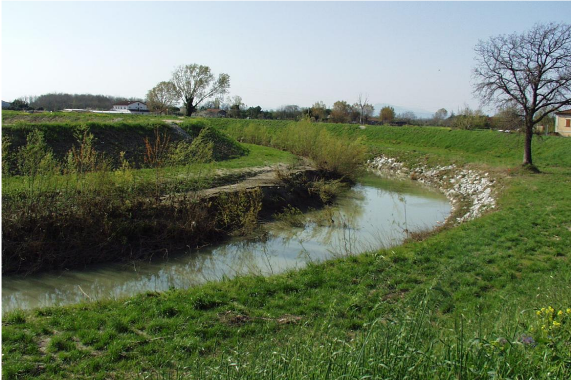
Fig. 7 – T. Uso. Sistemazione idraulica del tratto a valle dell'autostrada A14
