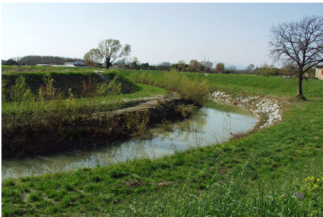
Figura 35 - T. Uso. Sistemazione idraulica del tratto a valle dell'autostrada A14
