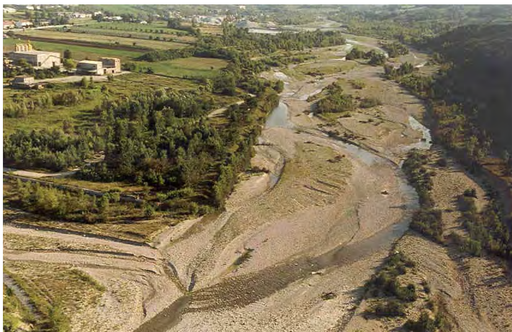
Figura 31 - Vista del F. Marecchia in loc. Campiano – Comune di Talamello
